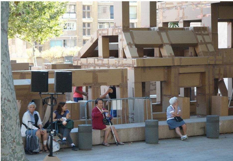
Le chantier de la Ville éphémère sous les regards des usagers habituels de la place Bargemon (photo MEB)
