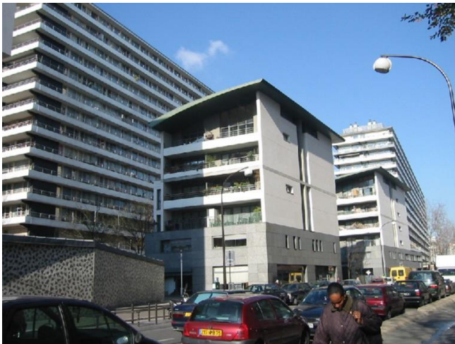
III. 8 : Rue nationale, Paris 13 e (Architecte C. de Portzamparc, 1995)
