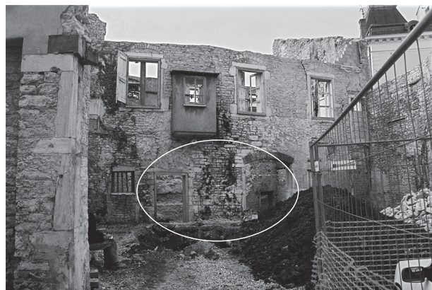
Fig. 362 - Maison Chanel, mur arrière du bâti intra-muros appuyé sur l'enceinte (cliché : équipe de fouille).
