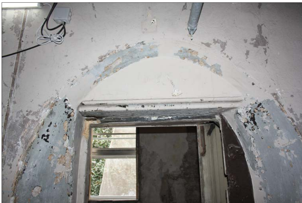
2. Fenêtre F 3/30 : détail de l'arc
