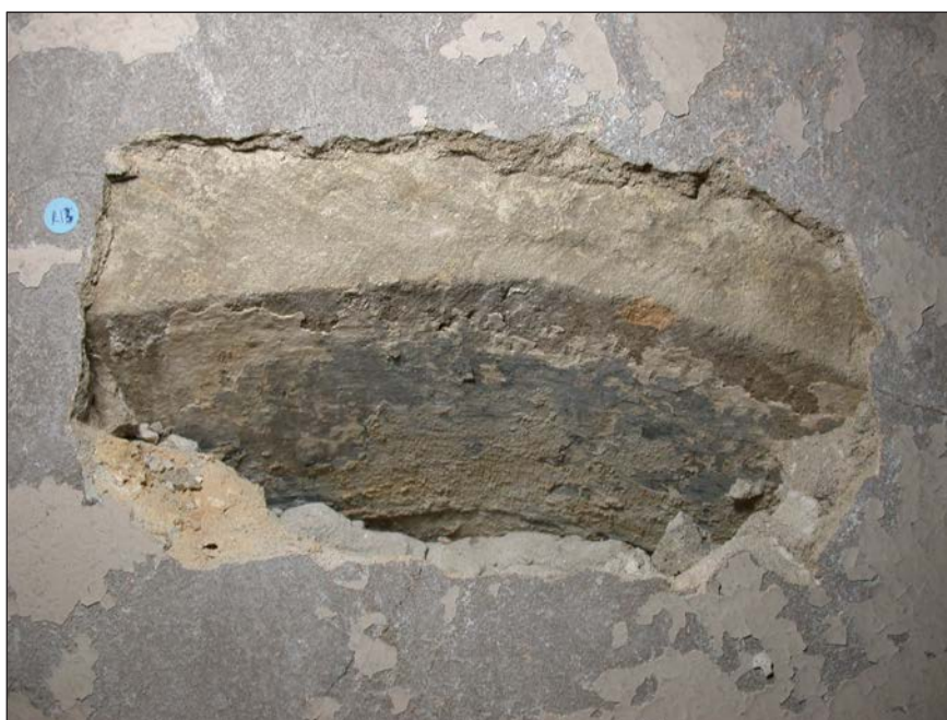
3. Détail des enduits observés sur l'arc de la fenêtre F 1/47
