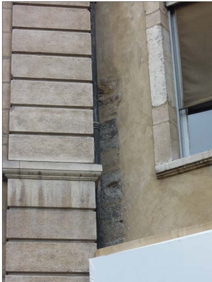
2. Piédroit ouest du porche derrière lequel apparaît le pilier d'une ancienne arcade (de l'aile ouest)
