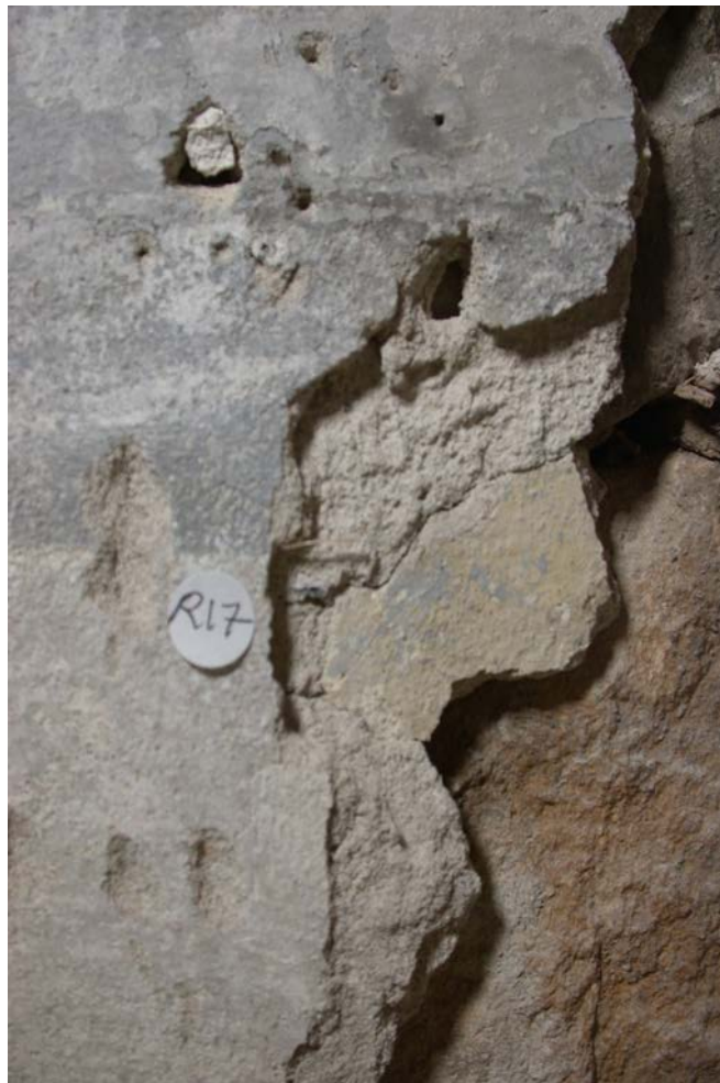
2. Mur nord, parement sud : détail des enduits observés sur l'arc de la fenêtre F 15
