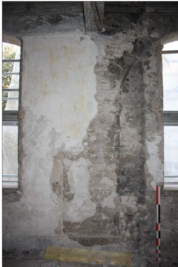
2. Portion de mur enduite : départ de l'arcade A 105, à droite
