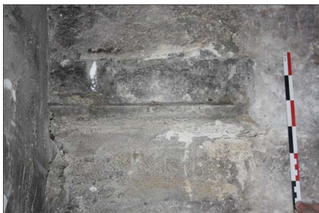
2. Détail du pilier (UC 20) de l'arcade A 102 : traces de boucharde
