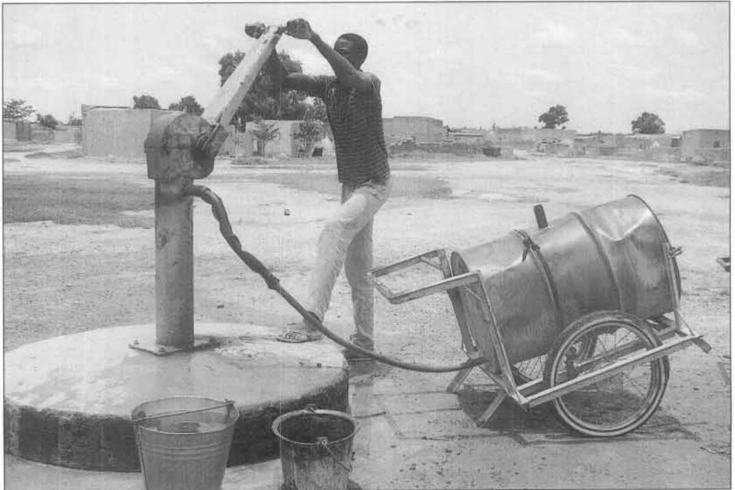
Forage équipé d'une pompe manuelle au marché de Cissin : il faut environ 20 mn à ce « pousseur de barrique » pour remplir son récipient (secteur 17, septembre 1987).
