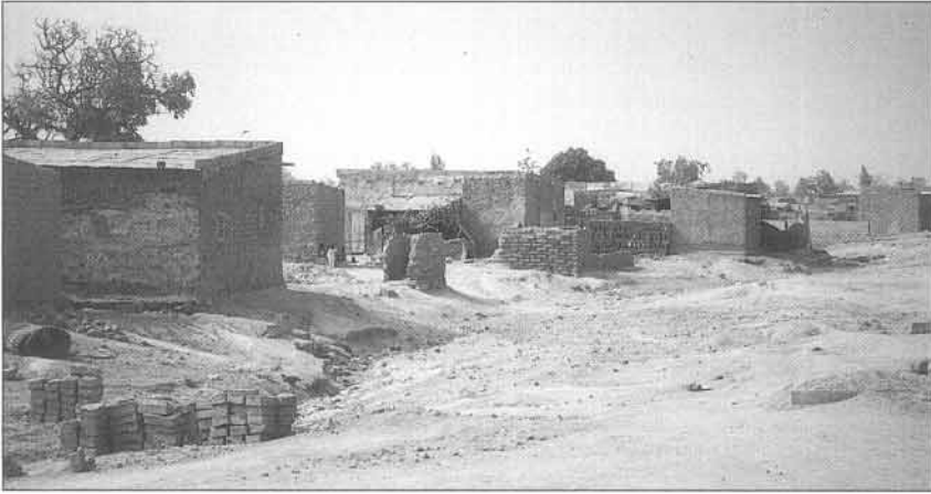
Déplacement des anciens bâtiments et reconstruction dans le cadre du nouveau parcellaire (secteur 17, février 1989).
