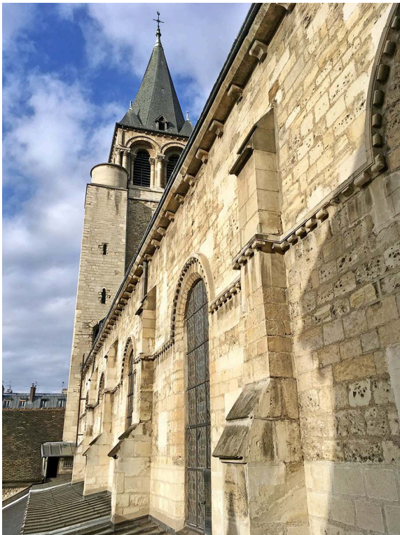
Fig. 8 – Vue de la tour Morard et du mur gouttereau sud de la nef
