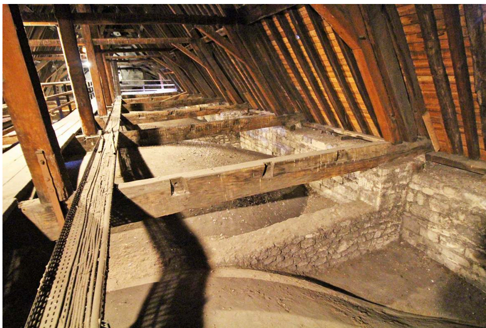
Fig. 10 – Comble de la nef. Entraits du XI e siècle réemployés dans la charpente du XVII e siècle
