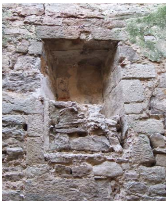
>Fig. 36 : Mur MR2031, parement interne, fenêtre FN2139
