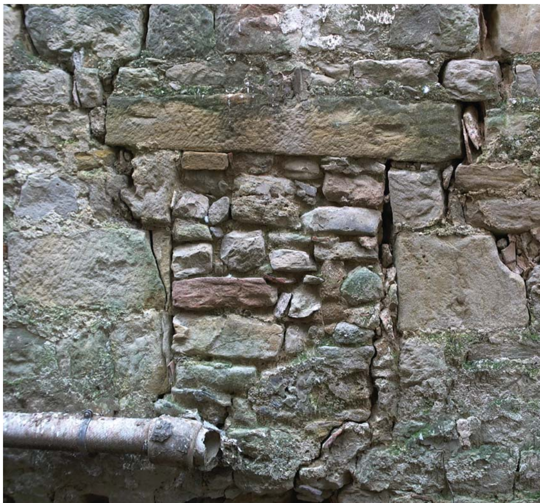
Fig. 35 : Mur MR2031, fenêtre FN2059
