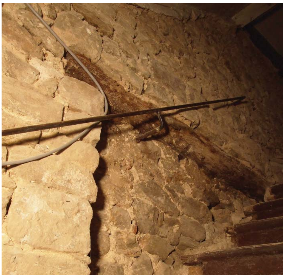
Fig. 11 : Porte PR1015, parement interne
