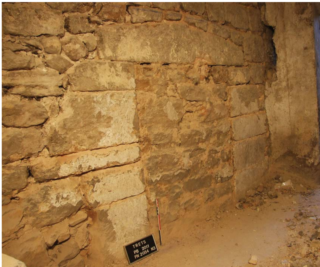
Fig. 34 : Mur MR2031, fenêtre FN2054
