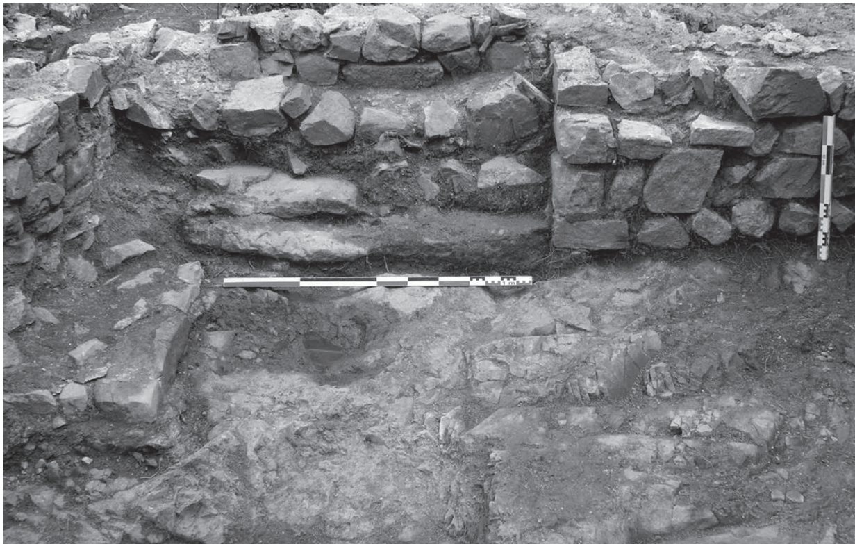
Fig. 12 La porte sud du chœur (cl. D. Martinez).
