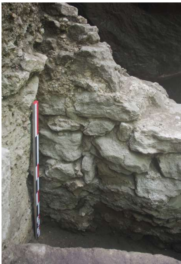
Fig. 32 : Parement et fondation nord de M 1002. Cliché : L. Benoit.
