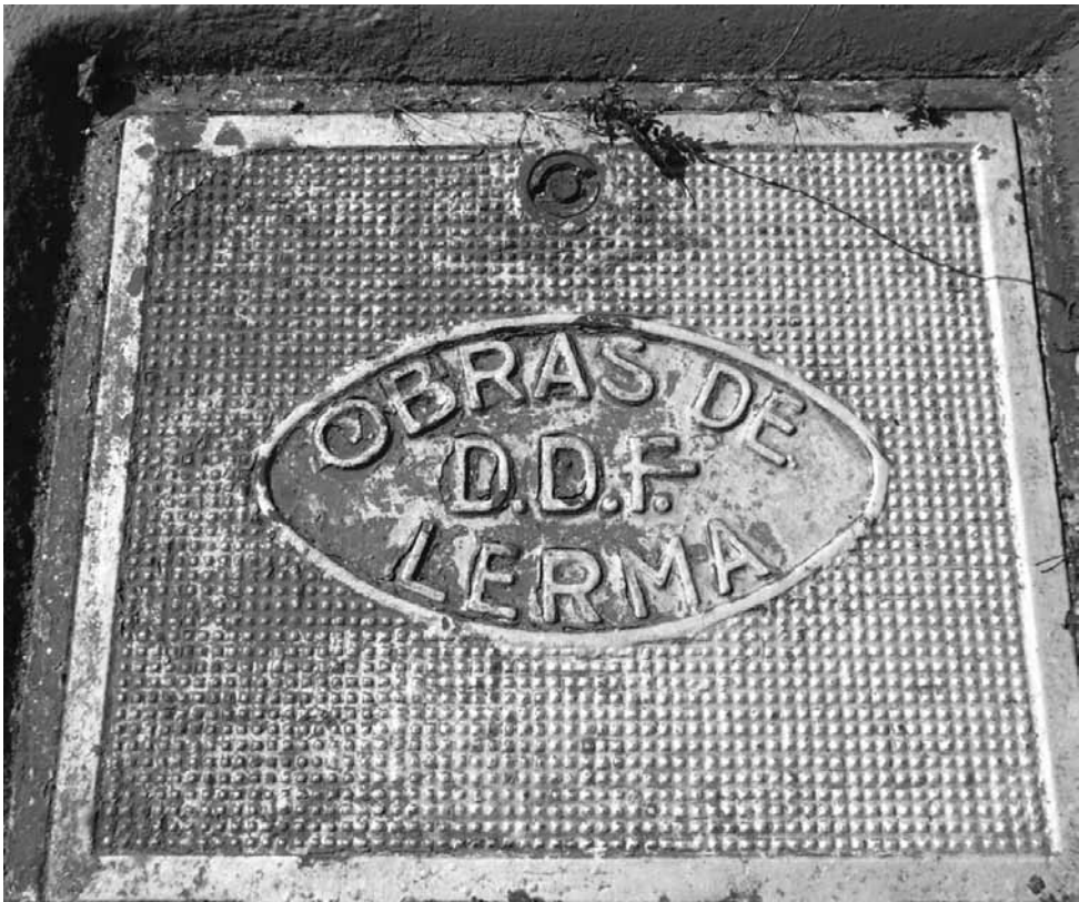
FOTO 2.2. TAPA DE COLADERA DE LAS OBRAS DEL DDF LERMA EN EL SISTEMA DE CAPTACIÓN "GRAL. MANUEL ÁVILA CAMACHO
