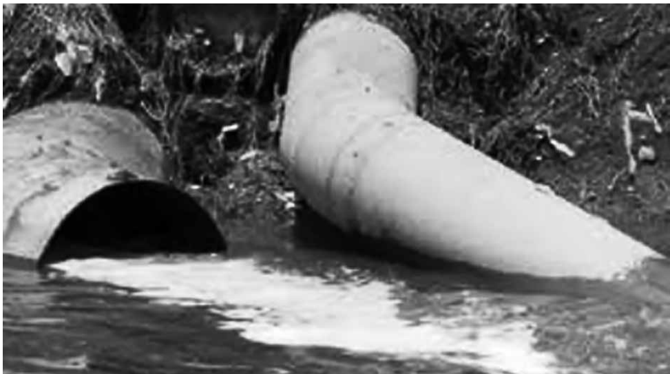
FOTO 5.2. CONTAMINACIÓN DEL RÍO LERMA (2)
