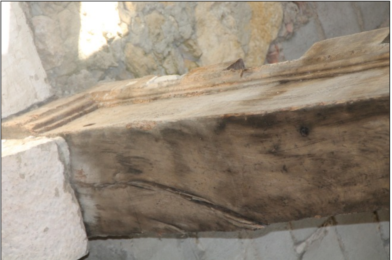
Doc. 58. Vue d'une moulure de poutre de la maison des jurats à Hastings. Photo S.A., 2017.
