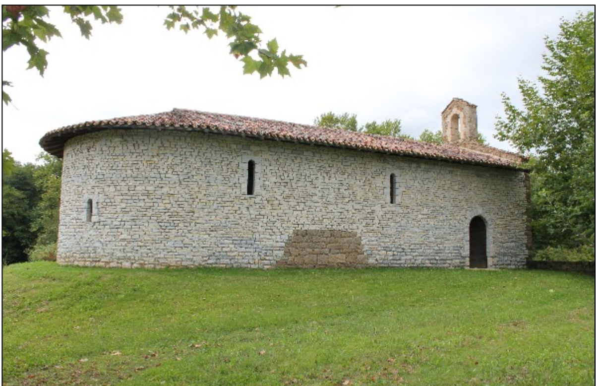
Doc. 17. L'église Sainte-Madeleine d'Otzantz. État en 2014. Les parties anciennes conservées sont construites avec un flysch plus sombre que le calcaire gris (pierre de Bidache) ayant servi à la reconstruction. Photographie S. A., 2014.
