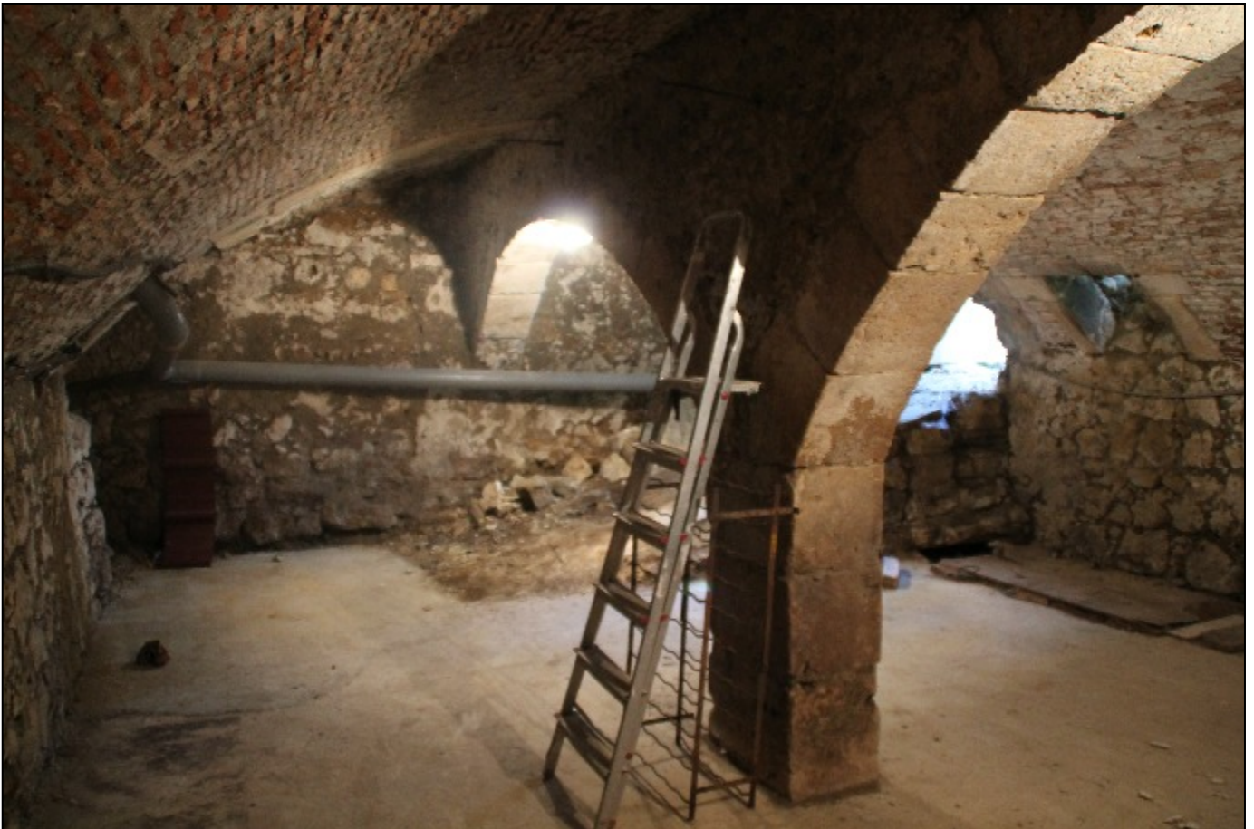
Doc. 56. Vue de la cave de la maison des jurats à Hastings. Photo S.A., 2017.
