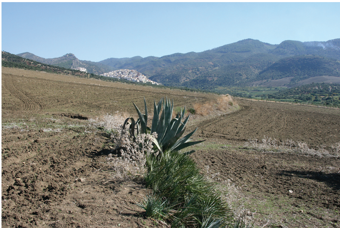
Fig. 20. La rupture de pente de l'aqueduc sud II, au sud de la route d'accès principale du site, entre T16 et T17 ( EauMaghreb ).
