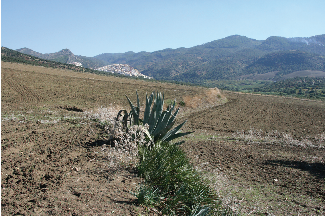
Fig. 20. La rupture de pente de l'aqueduc sud II, au sud de la route d'accès principale du site, entre T16 et T17 ( EauMaghreb ).
