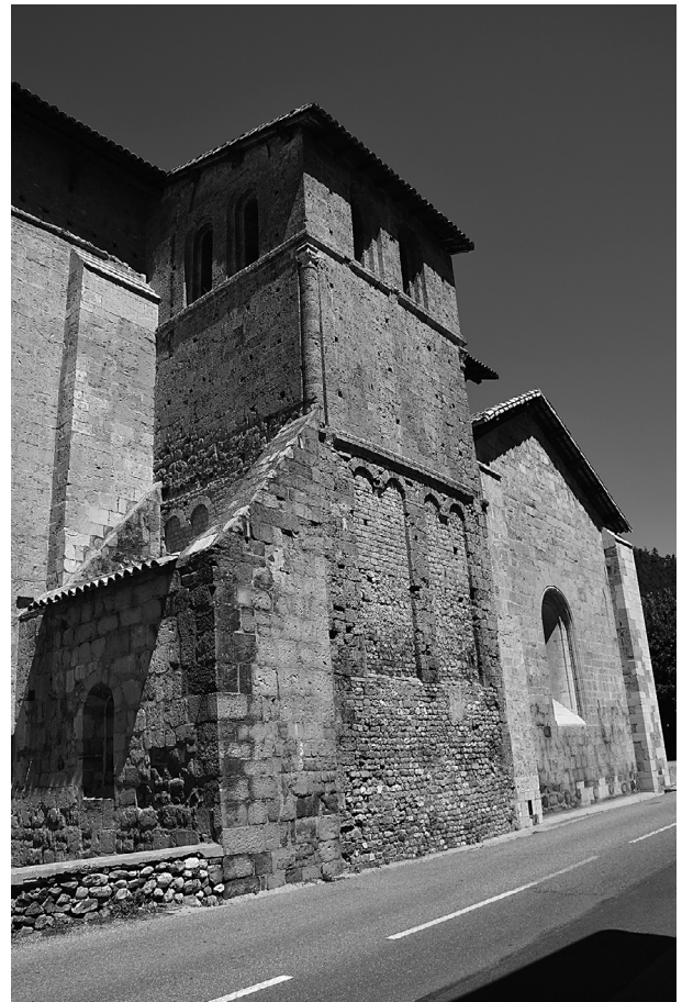
Fig. 15 : Digne-les-Bains : clocher roman intégré à la cathédrale Notre-Dame du Bourg lors de sa reconstruction (© Mathias Dupuis)
