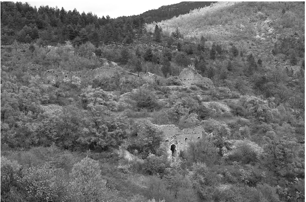
Fig. 18 : Castellane : le site de Petra Castellana vu depuis la montée du Roc. Au premier plan apparaît l'église Saint-Victor. Au second plan la partie nord de l'enceinte à tours pleines. (© Mathias Dupuis / SDA 04)
