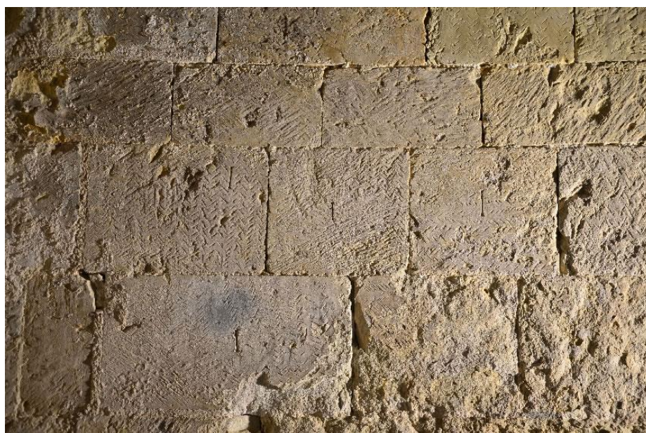
Castellane, chapelle Saint-Thyrse de Robion. Vue de détail d'un ensemble de « I » associés à des traces de taille décorative sur le parement intérieur du mur pignon ouest de la nef (SDA 04)
