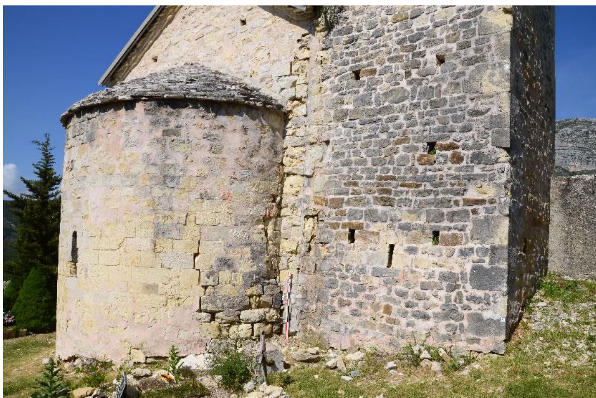
Castellane, chapelle Saint-Thyrse de Robion. Vue de détail du collage entre le clocher et le chevet de l'église depuis le nord-est (SDA 04)
