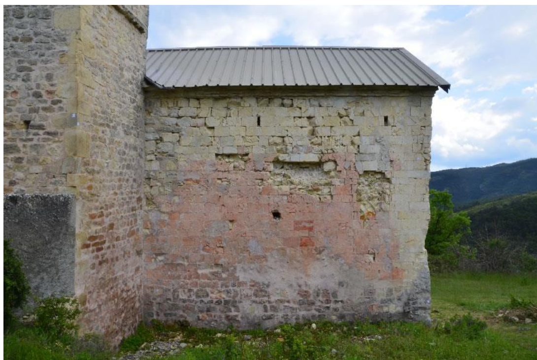
Castellane, chapelle Saint-Thyrse de Robion. Vue du parement extérieur du mur gouttereau nord de la nef (SDA 04)
