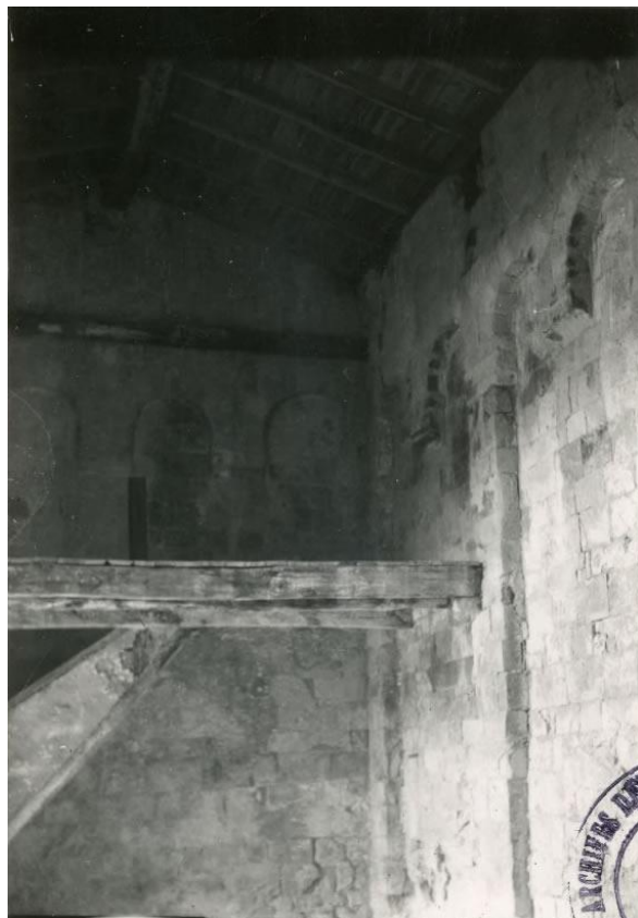
Castellane, chapelle Saint-Thyrse de Robion. Vue de la tribune et des parties hautes de la nef, depuis l'est, après 1942 (Archives dép. des Alpes de H.-P.)
