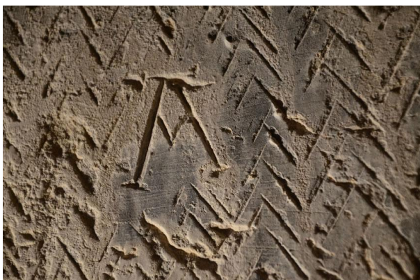
Castellane, chapelle Saint-Thyrse de Robion. Vue de détail d'un « A » et de traces de taille en chevrons sur le parement intérieur du mur gouttereau nord de la nef (SDA 04)
