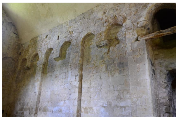
Castellane, chapelle Saint-Thyrse de Robion. Vue des arcatures aveugles sur le mur gouttereau nord de la nef (SDA 04)
