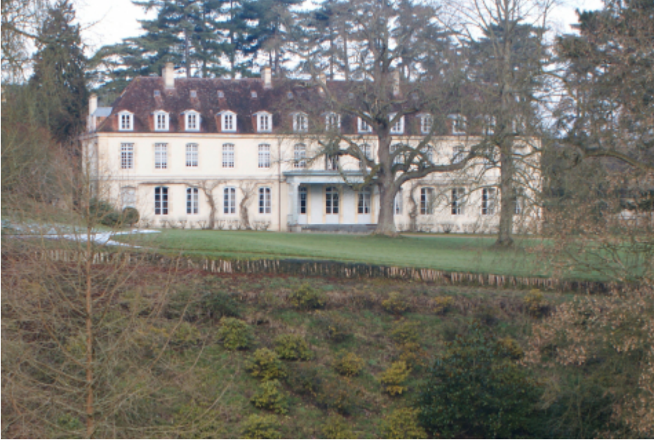
Fig. 3 Château du Val-Richer construit sur la plateforme du carré claustral, vue depuis le sud-est.
