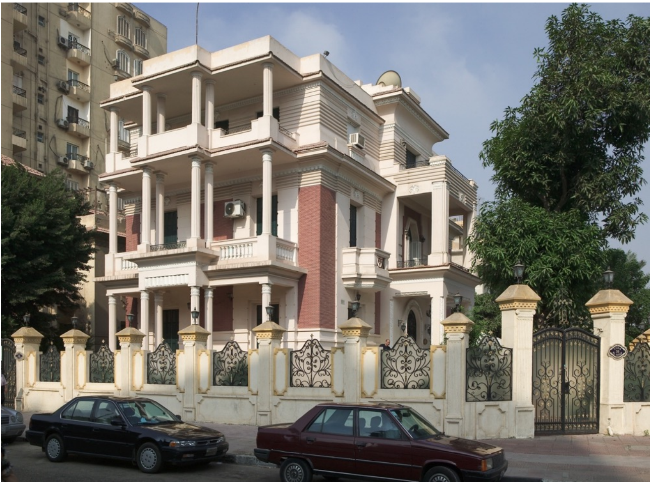
Fig. 10) Villa Al-Sayyad, 1933 (surélévation ajoutée vers 2000), Antoine Backh, architecte pour le projet initial (© Jean-François Gout/IFAO, 2004)
