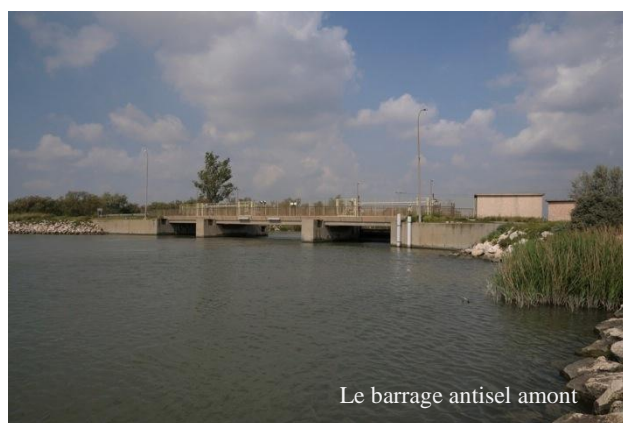
Figure 9 : Les aménagements réalisés par le Grand Port à partir de 1980, afin de pouvoir alimenter ses industries en eau douce.
