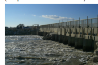
Aval des vannes de la Fourcade pendant un épisode de vent de Nord consécutif à une crue (photo P. Chauvelon)
