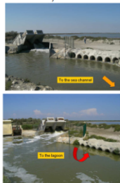
Fonctionnement de la station de l'Eolienne à la Fourcade (photos P. Chauvelon)
