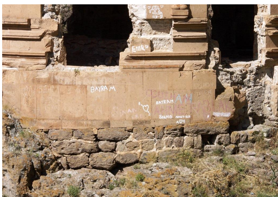
Fig. 31. Xckōnk'. St-Serge. Bas de la face est-nord-est, avec les assises bien taillées du cylindre de base et, sous elles, les assises de blocs plus grossiers compensant la déclivité du terrain. Photo de 2013.
