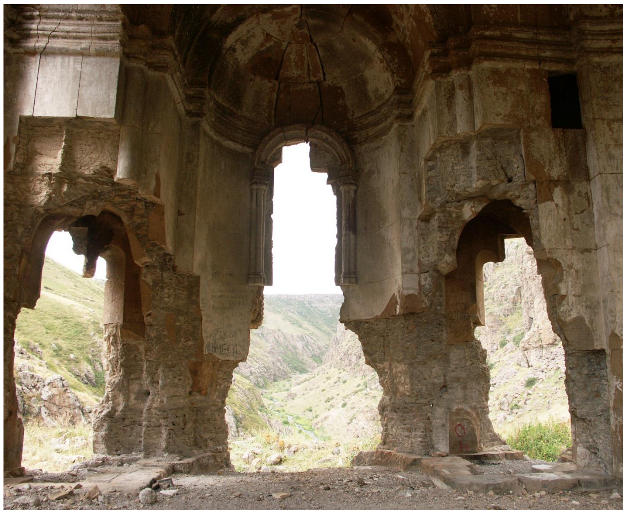
Fig. 128. Xckōnk'. St-Serge. Vue intérieure vers l'ouest. Photo de 2013.
