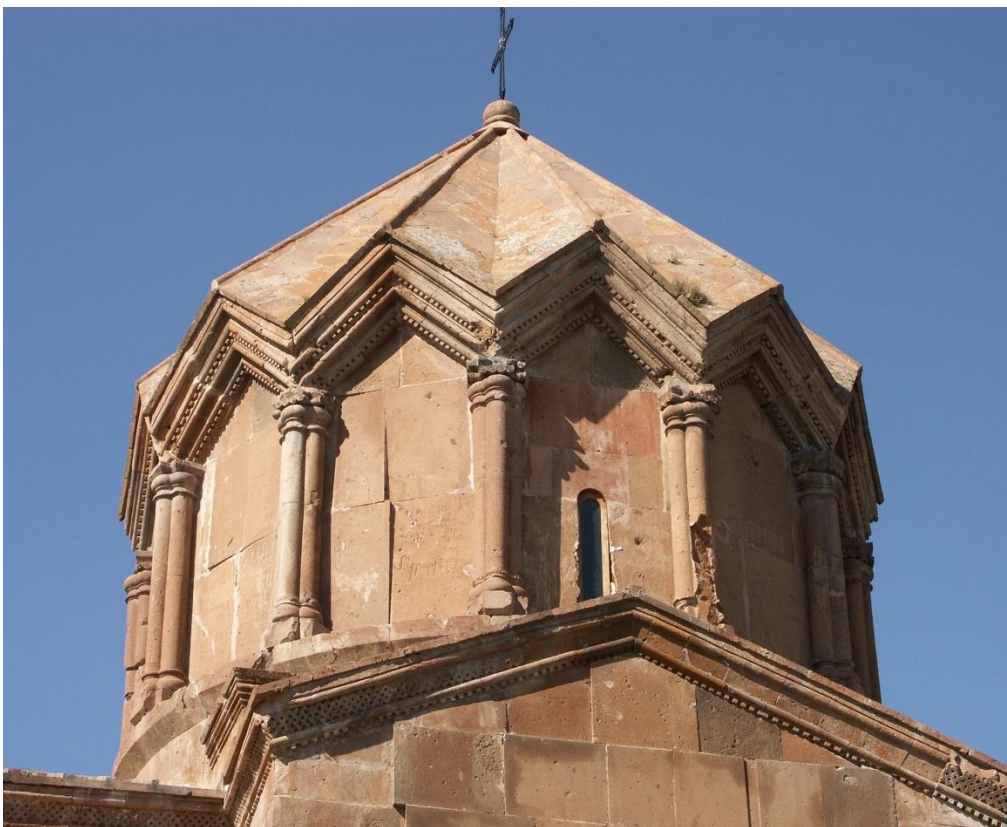
Fig. 53. Marmašēn. Église principale (1029). Tambour et dôme en ombrelle.
