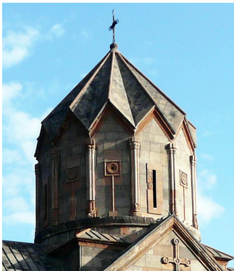
Fig. 57. Yovhannavank', monastère. Église principale Kat'olikē (1216-1221). Tambour et dôme en ombrelle.
