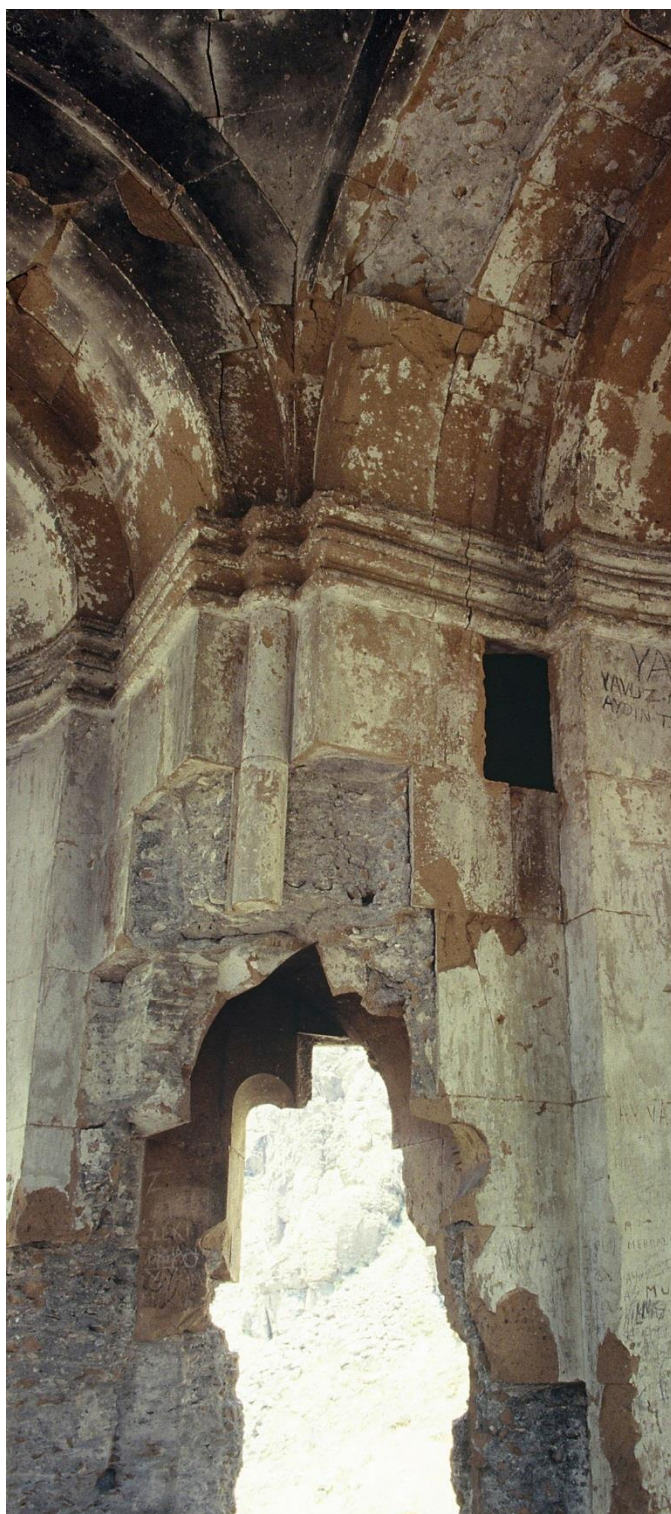
Fig. 120. Xckōnk'. St-Serge. Angle intérieur nord-est. Comparaison des photos de 1980 et de 2013 : une pierre en forme de demi-colonne est tombée.
