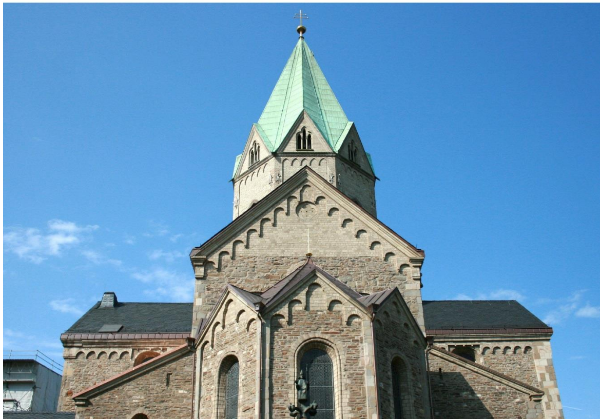
Fig. 109. Werden (Essen). Église St-Léger. Portion d'ombrelle à cinq plis sur l'abside (c. 1230). Détails de photos en ligne Von Beckstet - Eigene et https.commons , et Frank Vincentz et wikipedia.org .
