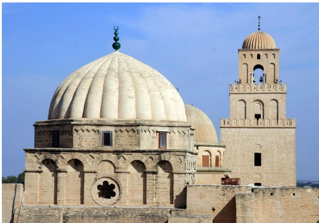
Fig. 89. Kairouan. Grande Mosquée (836). Photo Office National du Tourisme Tunisien et www.travelintunisia.be .
