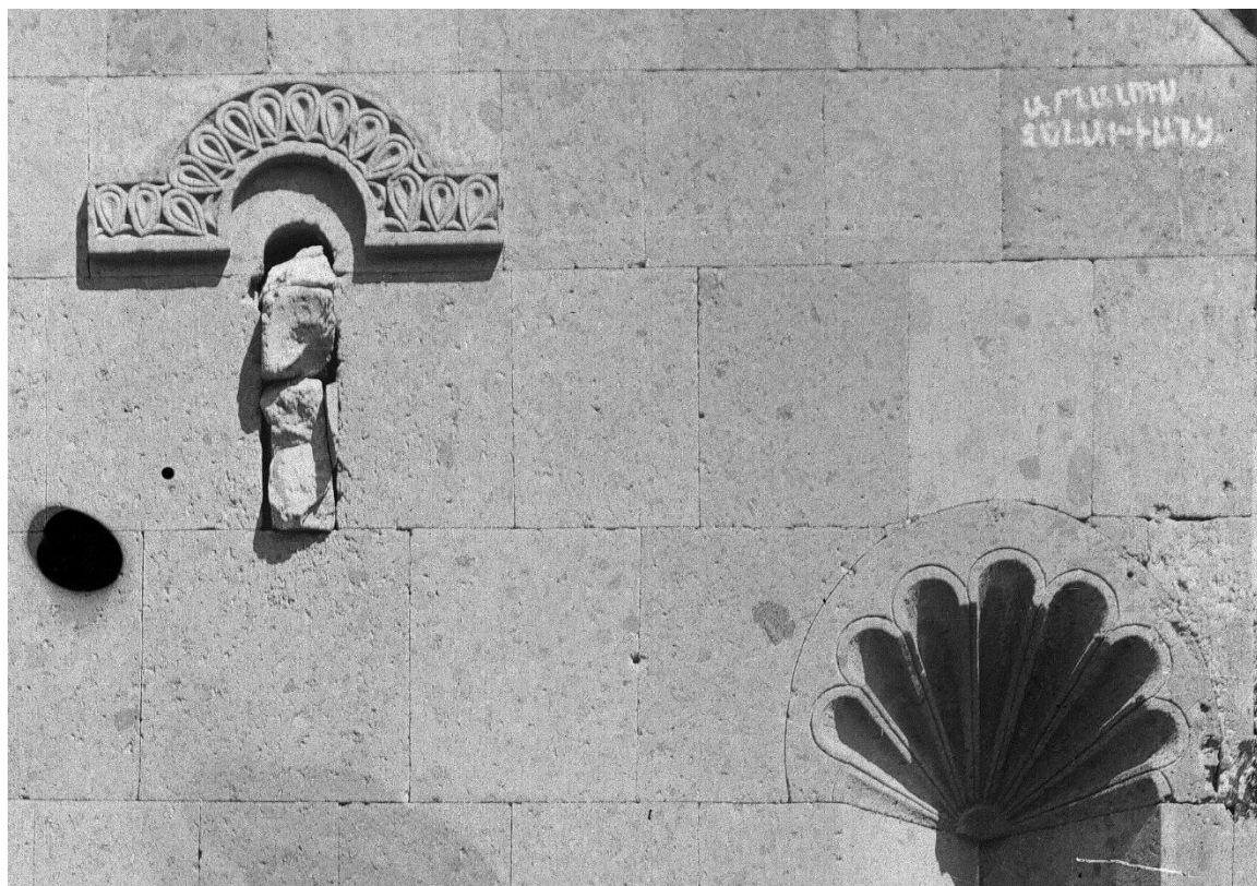
Fig. 16. Xckōnk'. Chapelle St-Etienne. Détails de la façade sud : ornement de la fenêtre centrale et trompe coquillée en haut de l'une des deux niches dièdres. Photo T'. T'oramanean, c. 1910, MHA n° 4390.
