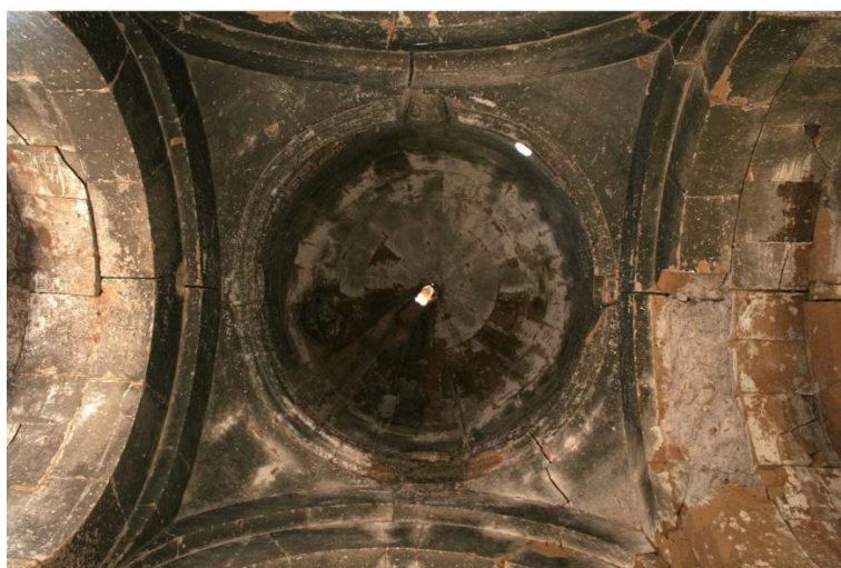
Fig. 122. Xckōnk'. St-Serge. Comparaison de photos prises par Steven Sim en 1986 et 2005 : trou apparu au centre de la coupole, probablement par suite du séisme de 1988.
