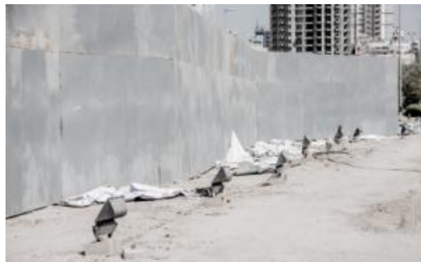
Figure 23 : Image à terre : remplacement des bâches publicitaires autour du chantier du nouveau quartier Hessah Al-Mubarak District, Koweït City, Benchetrit 2017.
