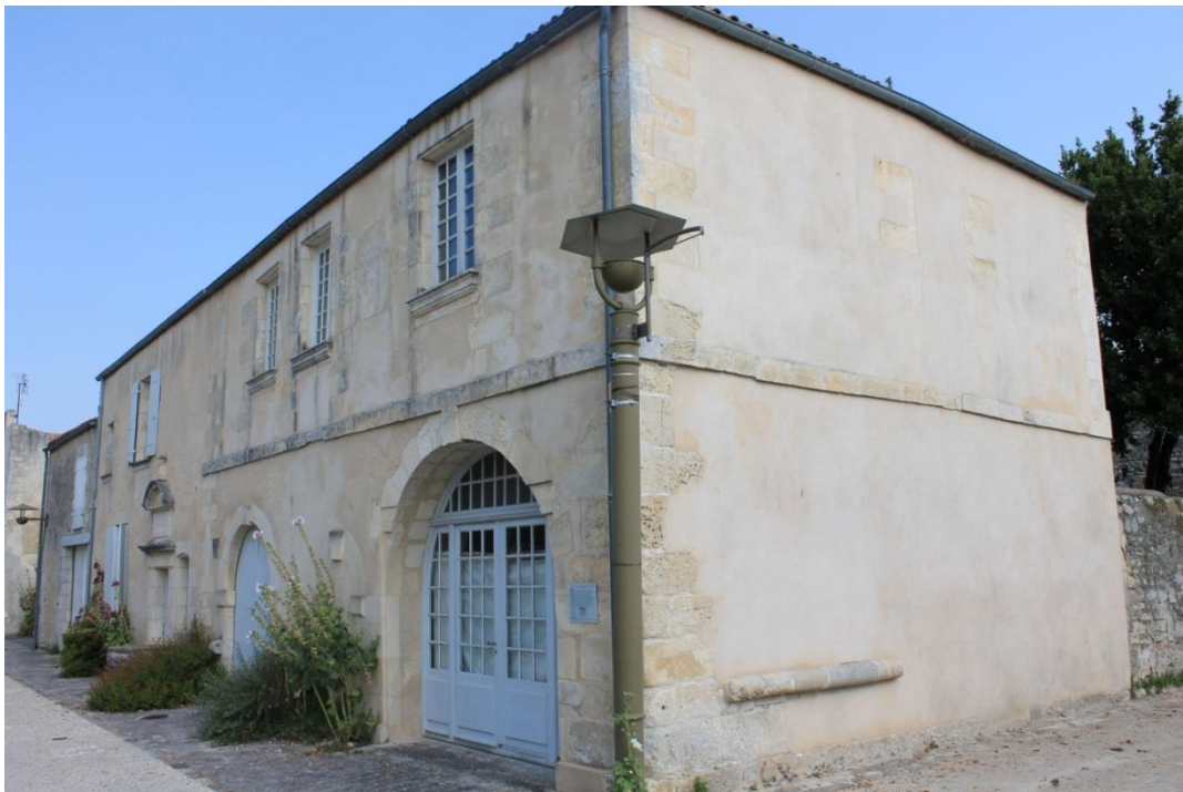
Fig. 2 : Maison inventoriée et restaurée de la rue de la Brèche (Brouage) (cliché C. Hubin, syndicat mixte pour la restauration et l'animation de Brouage)
