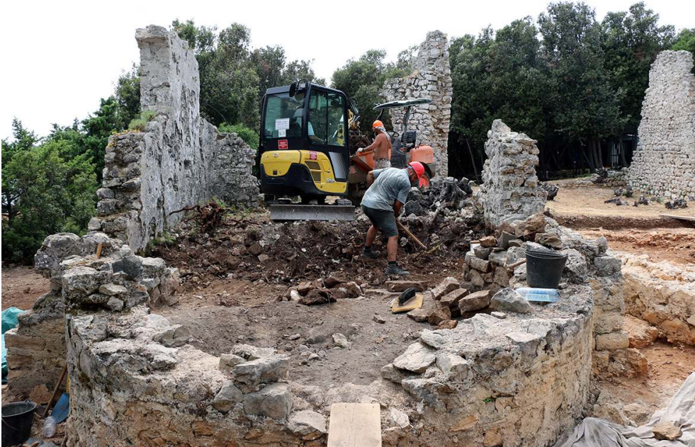
Fig. 5 – Travaux de décapage mécanisé à l'intérieur de la chapelle.
