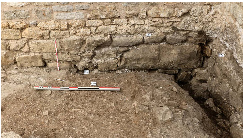
Fig. 4 – Secteur V, détail du remploi de grand appareil antique dans la fondation du mur est du vestibule roman.
