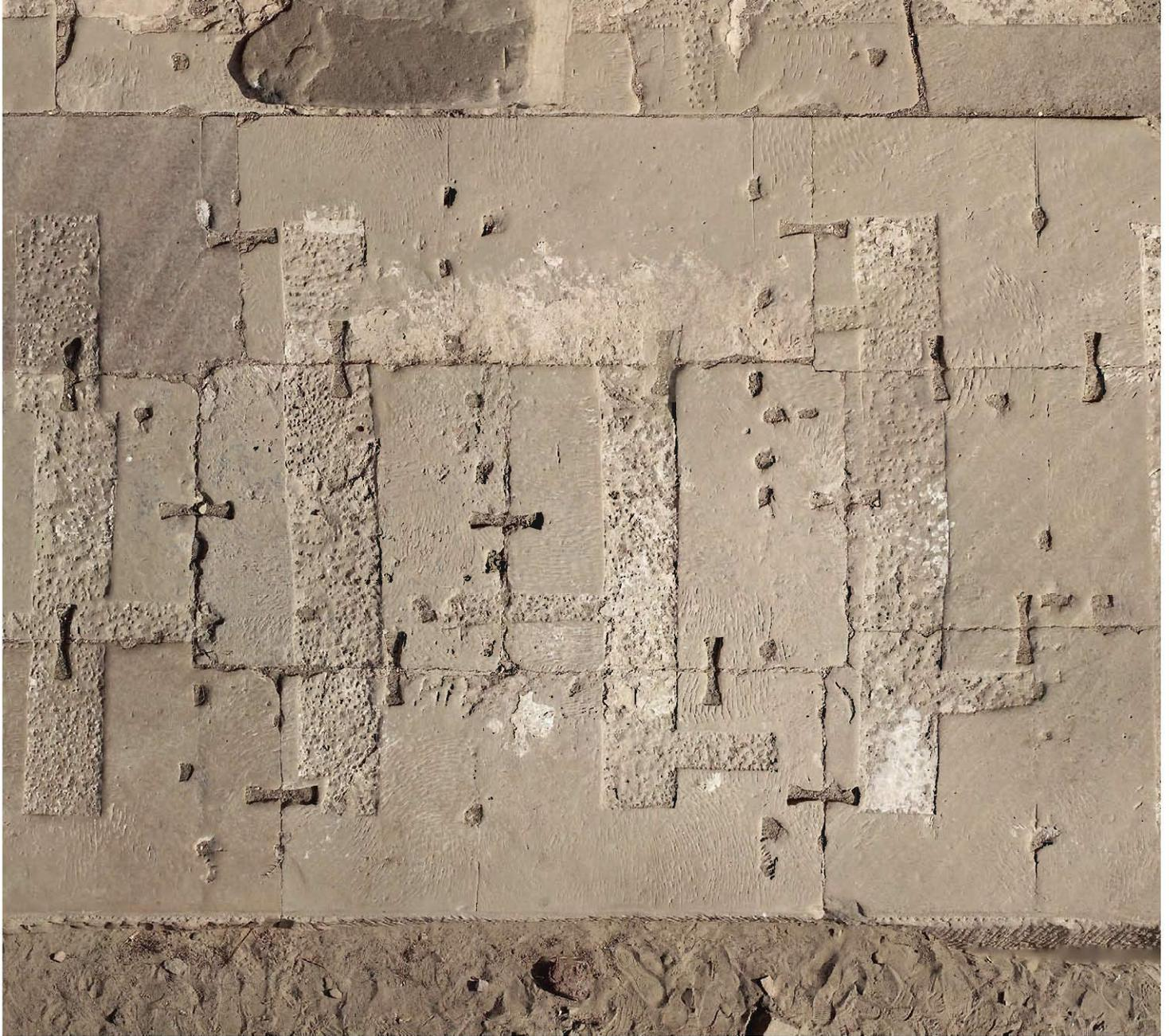
– une règle stricte : deux joints verticaux ne peuvent ni se faire face dans une assise horizontale, ni se superposer verticalement. Le chevauchement minimum des blocs peut être évalué à une quinzaine de centimètres ;
