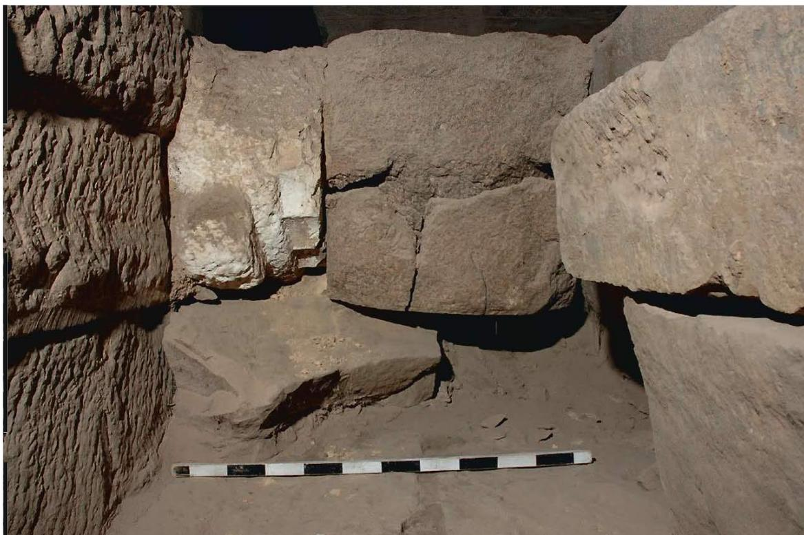
Fig. 7 Socle en granit d'Amenemhat III et fût de colonne en calcaire remployés dans les assises 8 et 9 de la salle 8 du temple d'Opet (© CFEETK / Y. Stoeckel)
