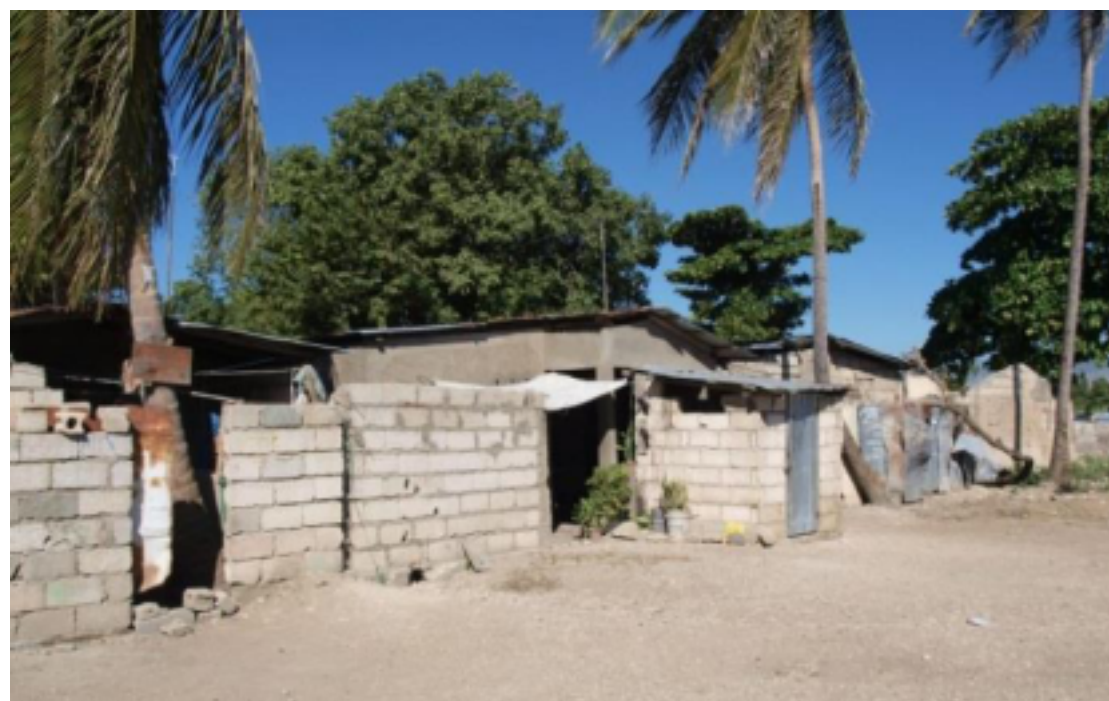
Figure 6. Logements reconstruits suite au séisme.
