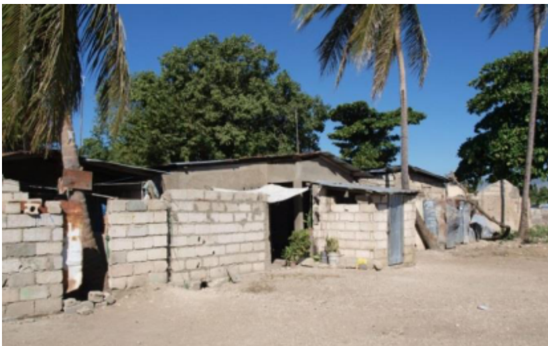
Figure 6. Logements reconstruits suite au séisme.
