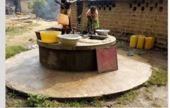
Puits grand diamètre équipé d'une PMH
