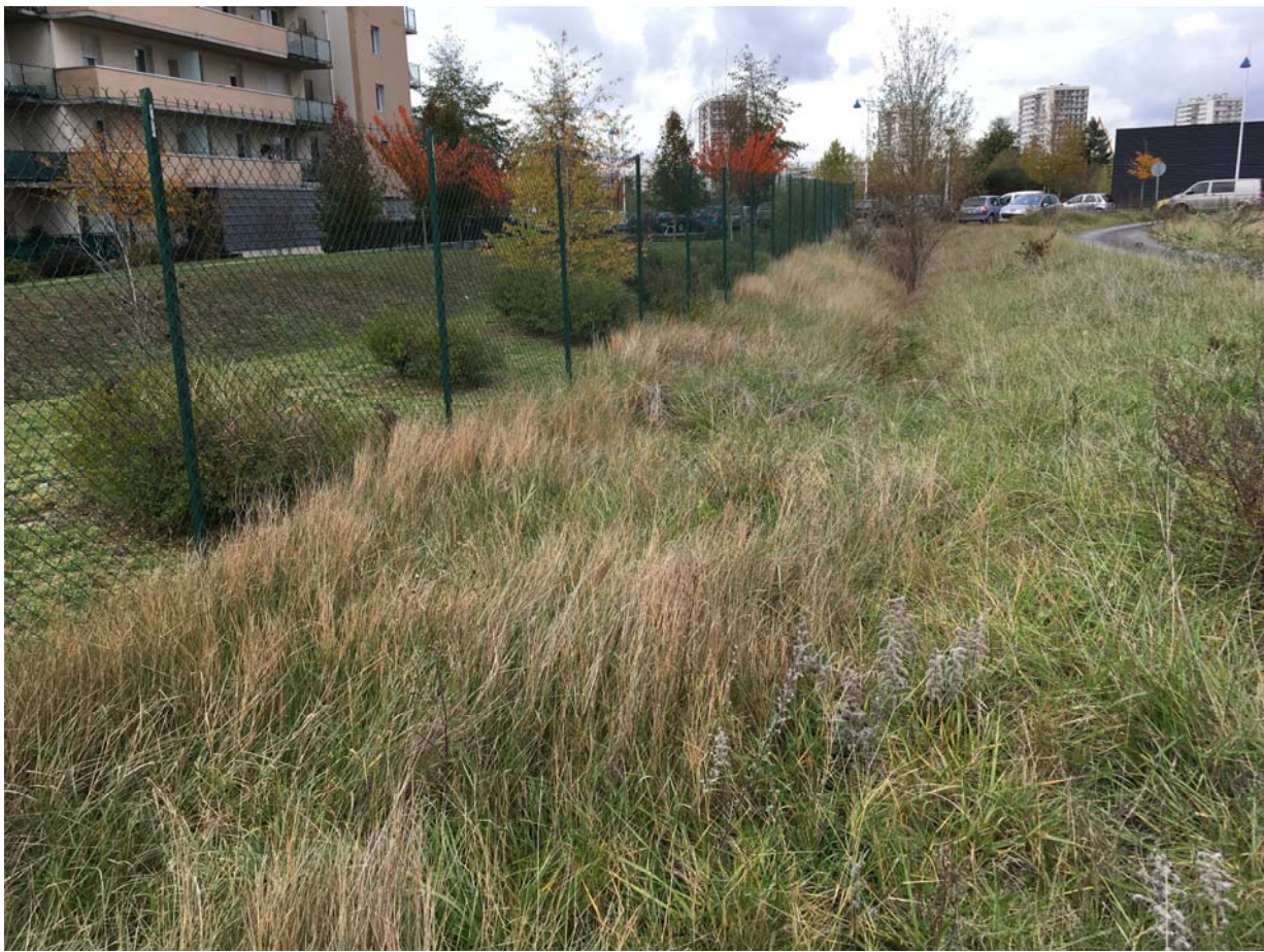
Figure 5. Des noues d'écoulement des eaux occupées par la végétation dans le quartier des Deux Lions à Tours
