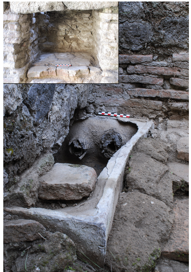
Fig. 13. Chauffe-eau en plomb inclus dans le four de la boulangerie VII 12, 11. La face supérieure ayant disparu, on voit les tuyaux de remplissage et de vidange dans la paroi. En encadré, chambre de chauffe du même aménagement, vu de l'autre côté (clichés N. Monteix).
