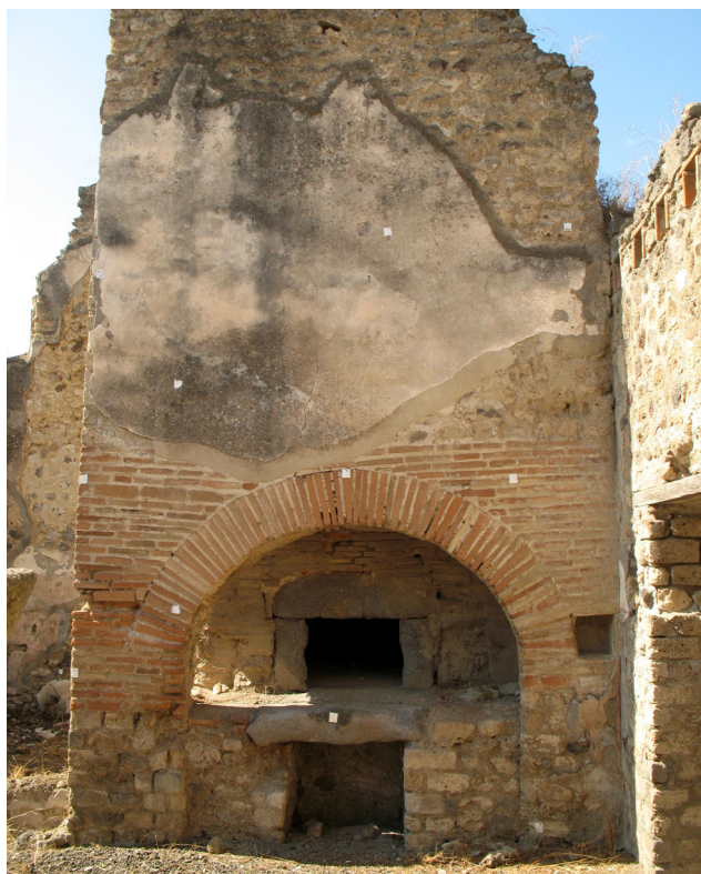
Fig. 16. Vue générale du four en V 4, 01-02. En avant de la gueule du four et de l'autel se trouve le mur diaphragme, avec son arc caractéristique. Notez les changements d'appareil entre les zones inférieure et supérieure de la paroi (cliché A. Coutelas).
