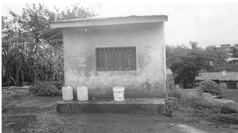
*Photo 2 : Point d'eau SNEC du programme FOURMI au quartier Djeleng 5 à Bafoussam On peut apprécier le dispositif de sécurité marqué par la petite case dans laquelle se trouve la borne fontaine, ce qui évite le vandalisme sur l'ouvrage. Elle ouvre à des heures régulières.*
