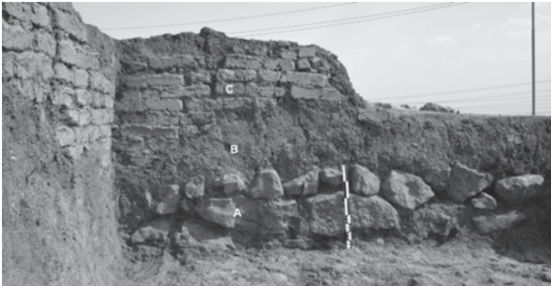
Fig. 37: Mur 215 © Mission archéologique du Peramagron.
