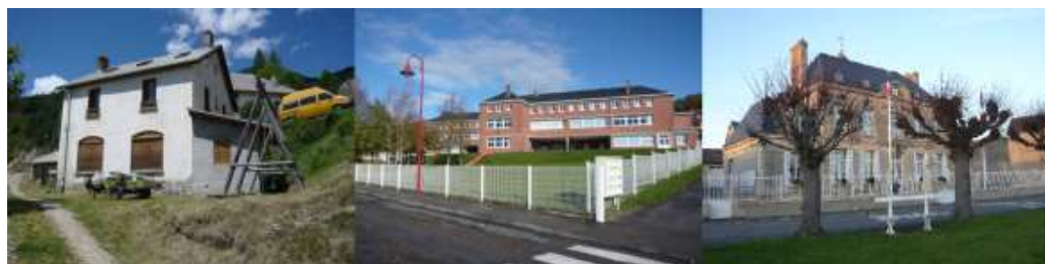
Ecole désaffectée du hameau Les Meyries Commune de Château-Queyras (05)
