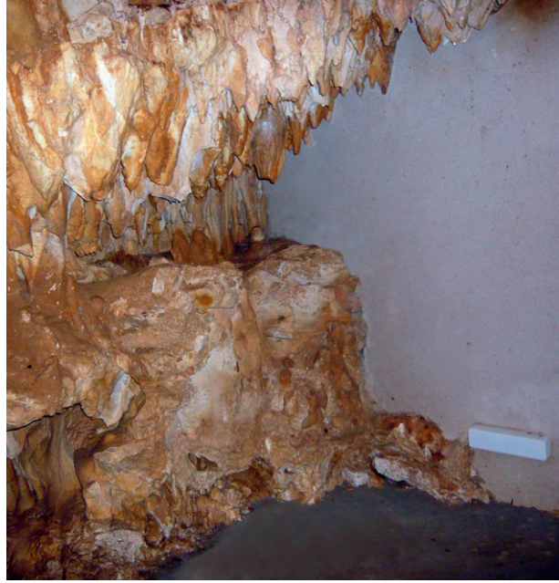
Fig. 69 – Fond de la Salle des Peintures dans le sas de sortie créé en 1958, en arrière du mur de séparation avec la Salle proprement dite. Il montre la voûte hérissée de stalactites plongeant vers la surface de l'éboulis terminal en formant une niche surbaissée.
