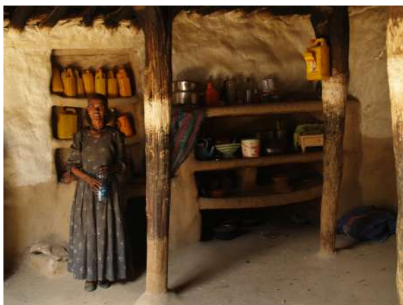
FIGURE 10.10 – Intérieur de la maison de Zemeda Hailu. Remarquer les piliers en genévrier, qui soutiennent la toiture. Cliché : N. Blond, 2017.
