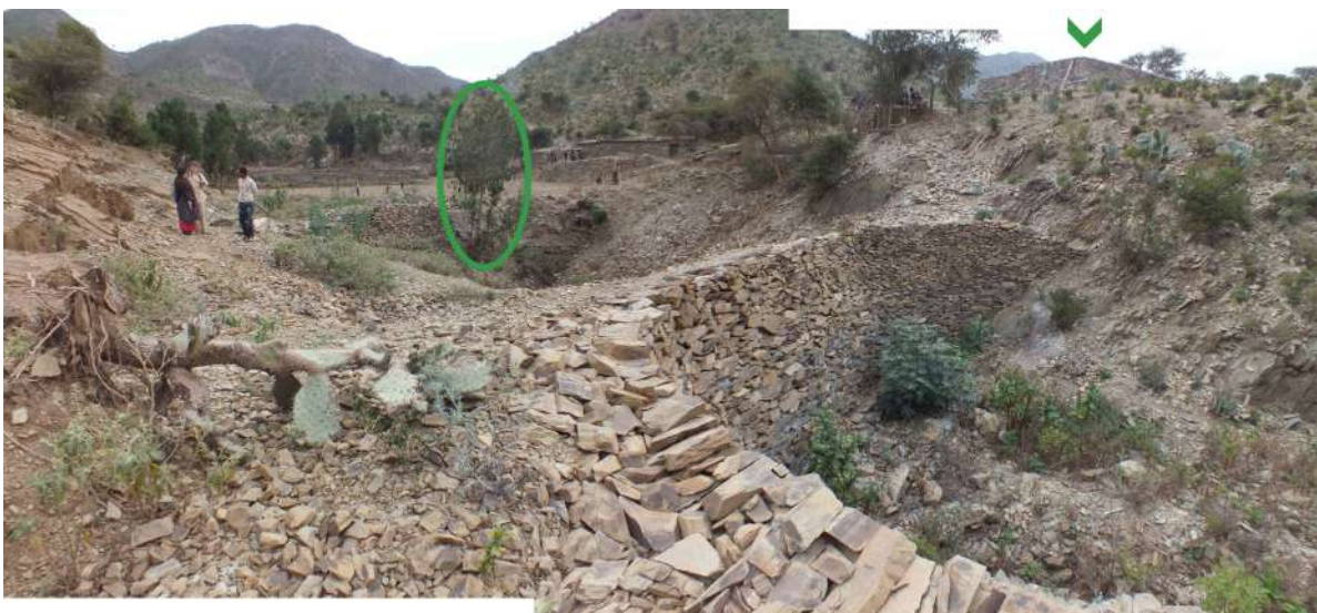
FIGURE 6.9 – Barrage de Ka Ebile en 2013. Cliché : Y. Callot, 2013.
