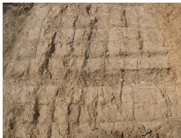
FIG. 10 : Chantier A, mur (niveau 2), détail des briques
