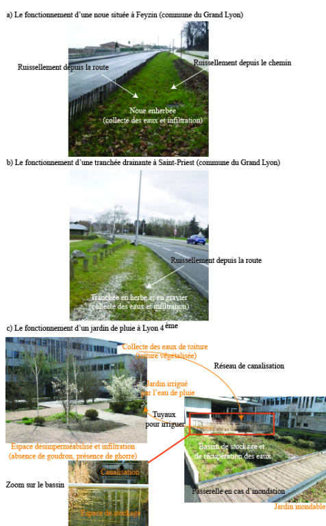
Figure 3. Les dispositifs techniques à la source : un cycle hydrosocial fondé sur la désimperméabilisation, le ruissellement et l'infiltration
