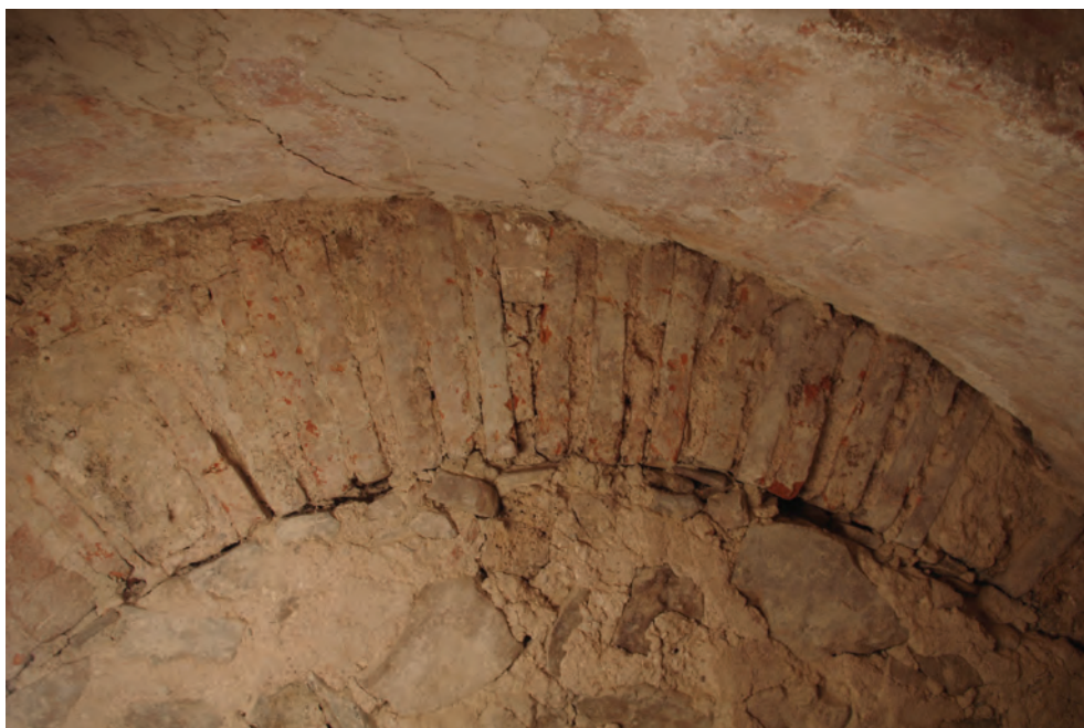
a. Sommet de l'arc correspondant à une réfection.
