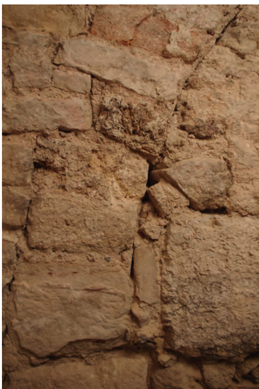
b/c. Extrémités du linteau qui, à l'ouest comme à l'est, n'est pas ancré dans l'encadrement de l'ancienne ouverture.
