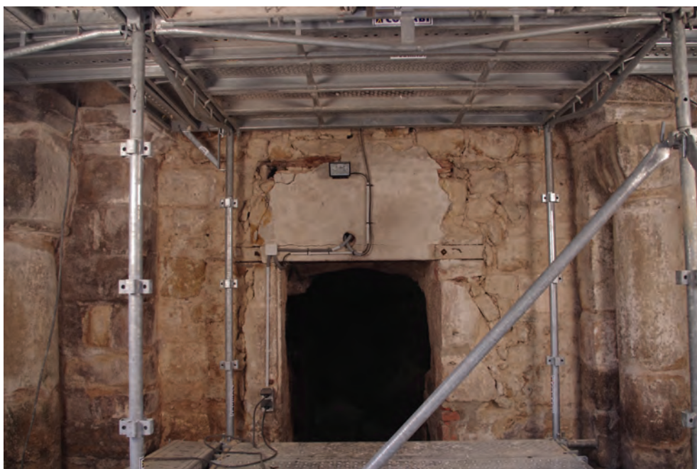
b. Vue d'ensemble après décroûtage.
