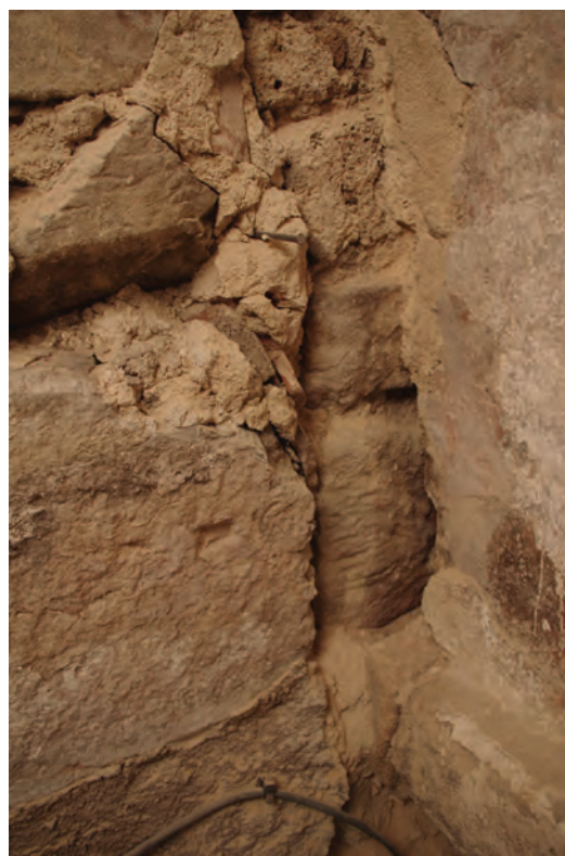
b/c. Extrémités du linteau qui, à l'ouest comme à l'est, n'est pas ancré dans l'encadrement de l'ancienne ouverture.
