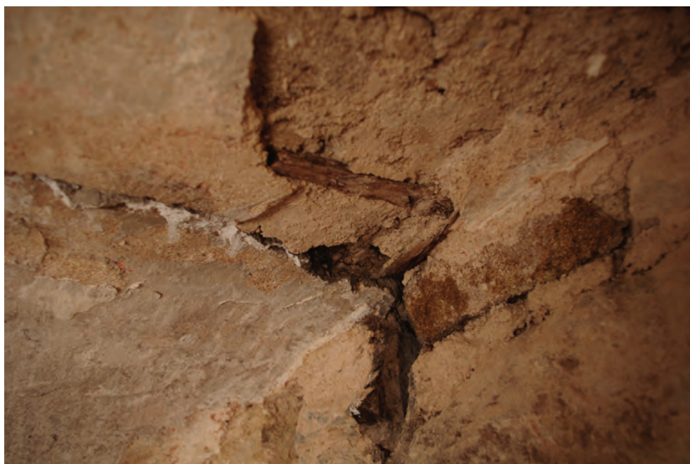
b. Morceau de bois pris dans l'enduit originel de l'arc.
