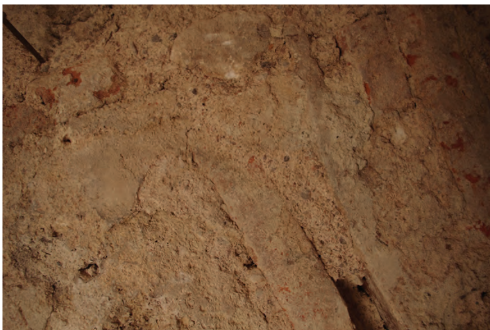
b. Mortier de construction entre les claveaux de brique de l'arc.
