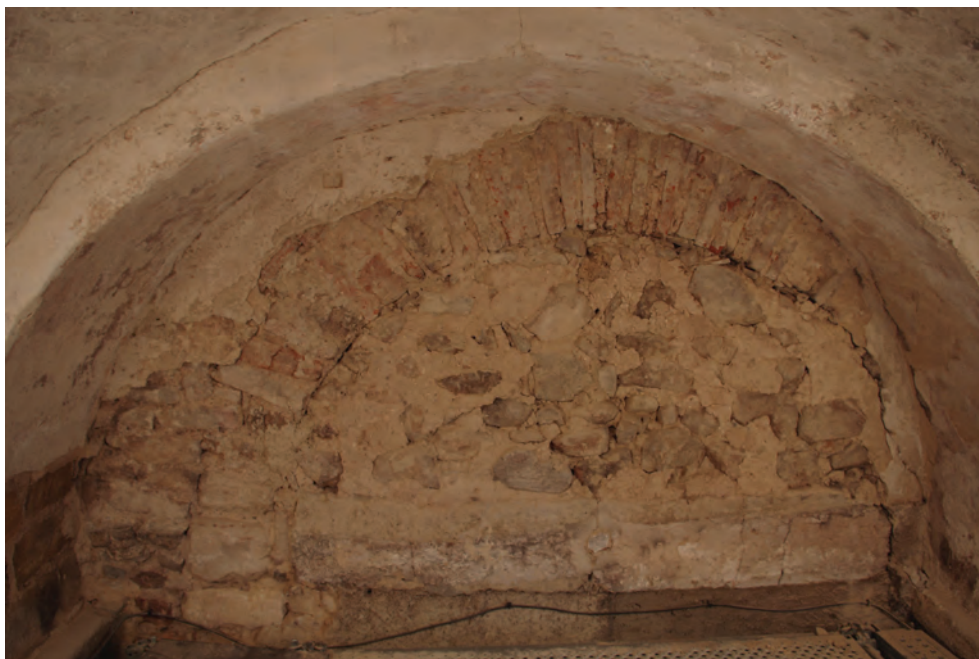
a. Sommet du mur, ponctuellement couvert par l'enduit moderne, avec l'arc bouché de l'arcade menant à l'église.
