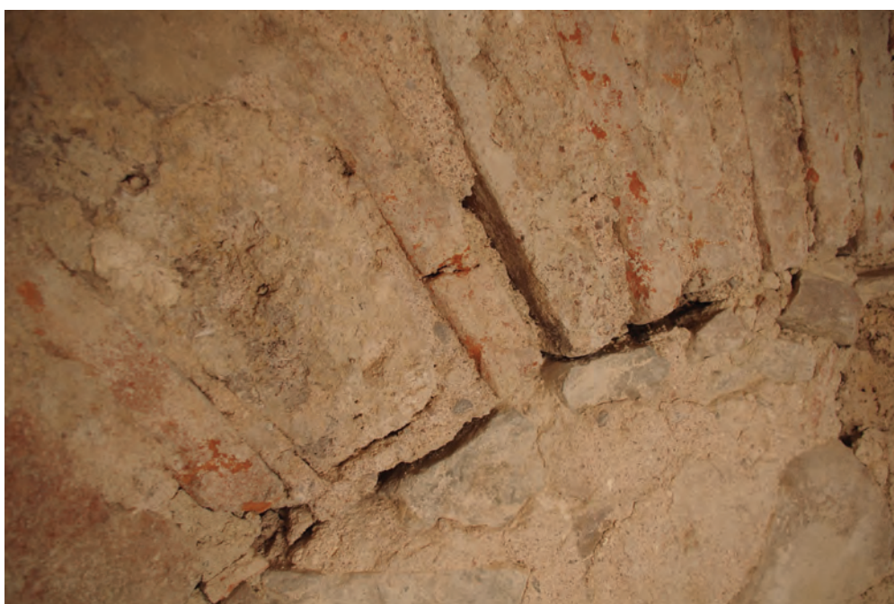
b. Jonction entre l'arc originel (briques et pierres alternées) et la réfection (briques uniquement).
