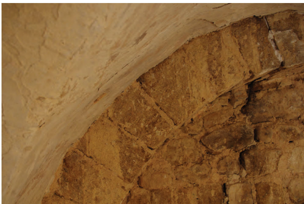
b. Traces de l'enduit originel ayant coulé sur certains claveaux de l'arc.
