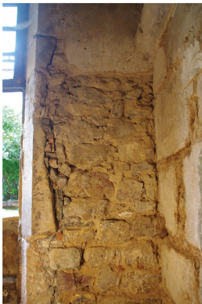
c. Bouchage de l'ancienne fenêtre.
