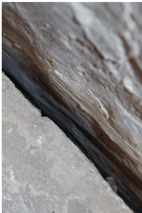
b. Jonction entre le mur et l'arc qui se prolonge nettement derrière le doublage intérieur
