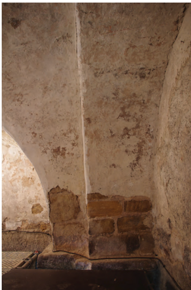
a. Retombées de l'arête de la voûte et de l'arc nord.
