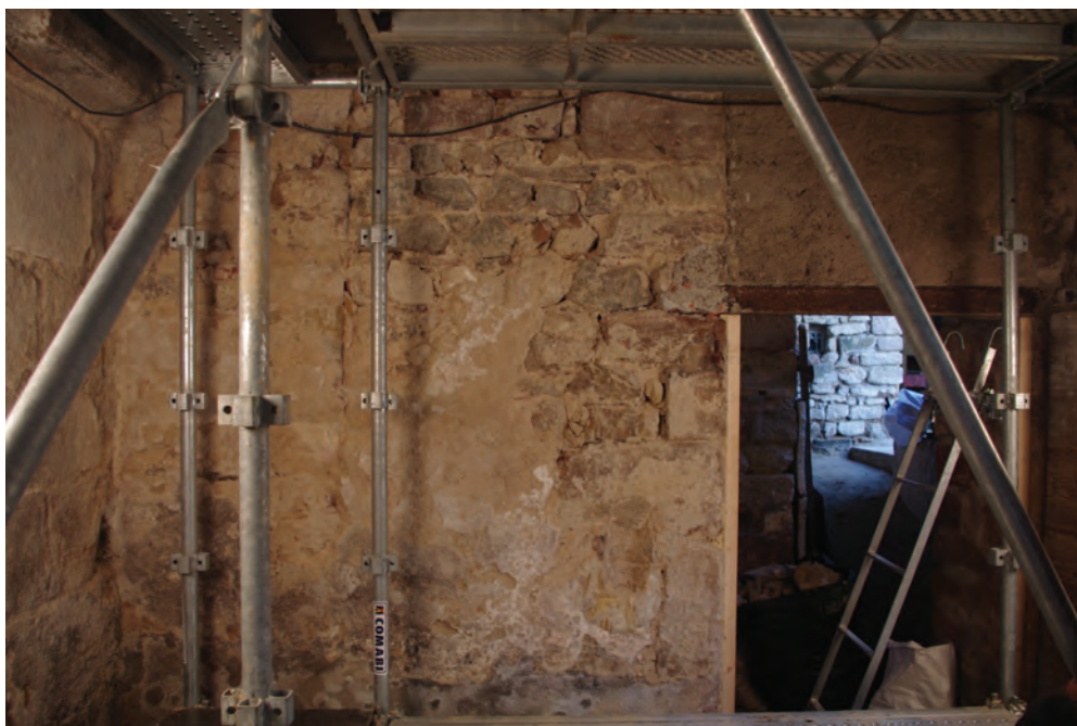
b. Partie basse : le piédroit ouest de l'ancienne arcade, ainsi que son bouchage partiel, se distinguent sous l'enduit moderne.
