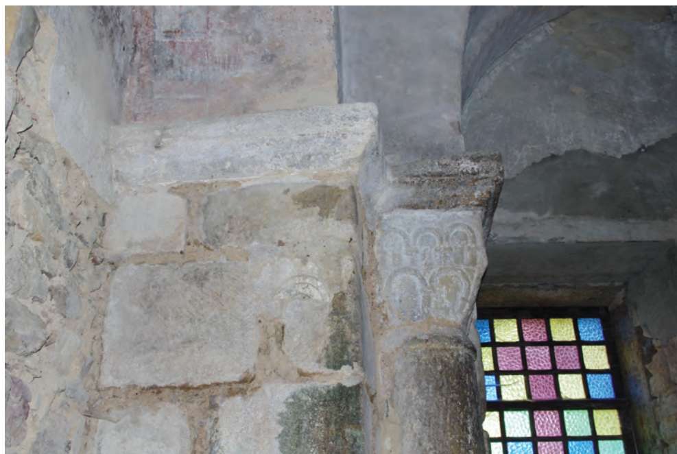
b. Massif d'angle sud-est, sommet du pilier est et de la colonne avec son chapiteau à arcatures.
