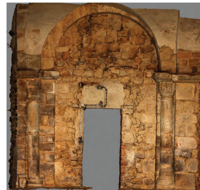
h. Mur ouest.
