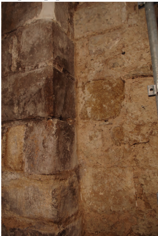
b. Jonction entre le mur et le massif d'angle sud-ouest.
