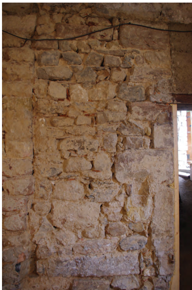
a. Maçonnerie du bouchage.
