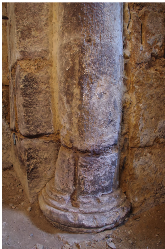
b. Base de colonne intégrée au premier tronçon du fût.
