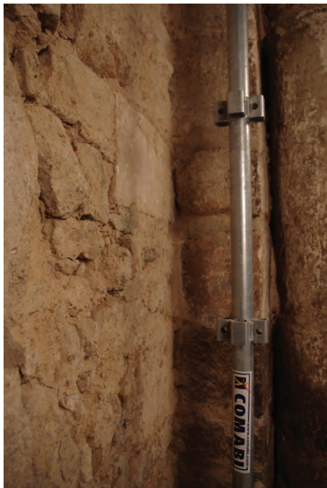
b. Jonction entre le mur et le massif d'angle nord-ouest.
