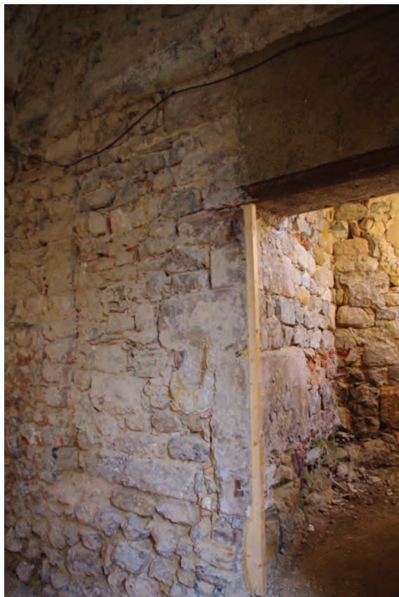
a. Extrémité sud du mur bouchant l'ancienne arcade du mur nord de la chapelle.
