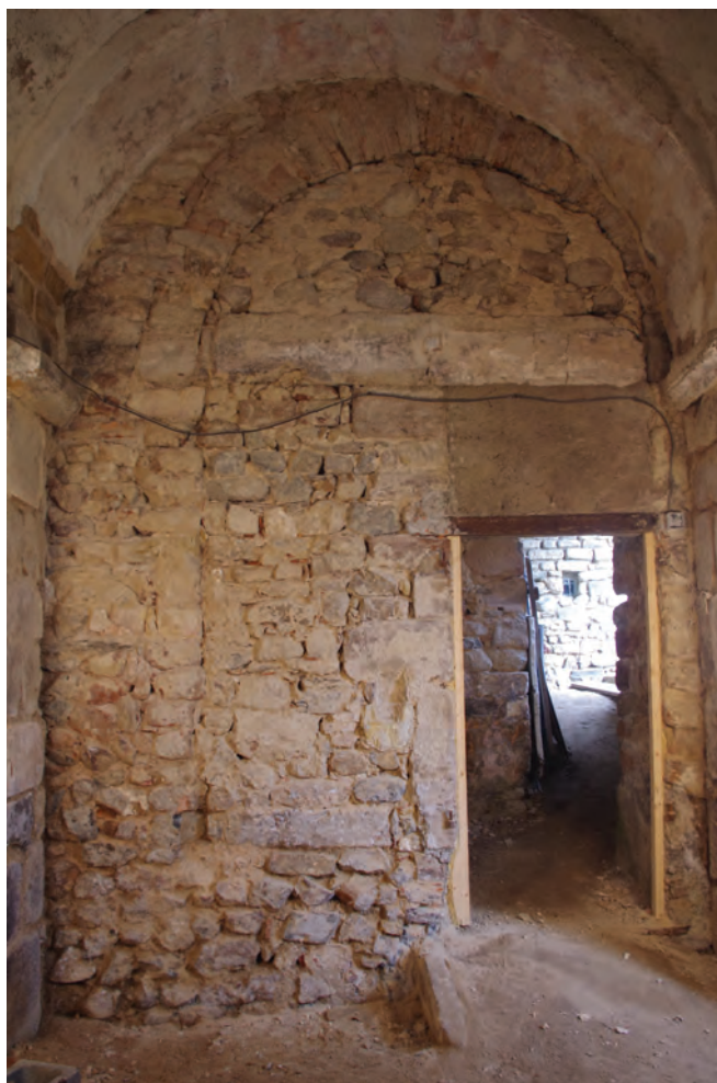
a. Vue d'ensemble après décaissage complet.
