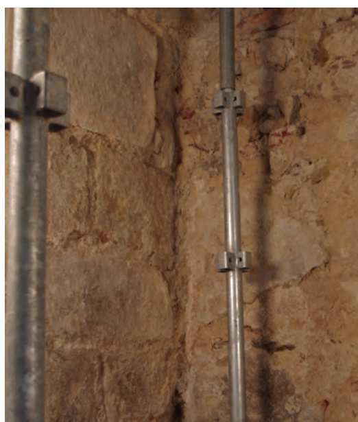
b. Jonction entre le massif d'angle nord-ouest et le mur.
