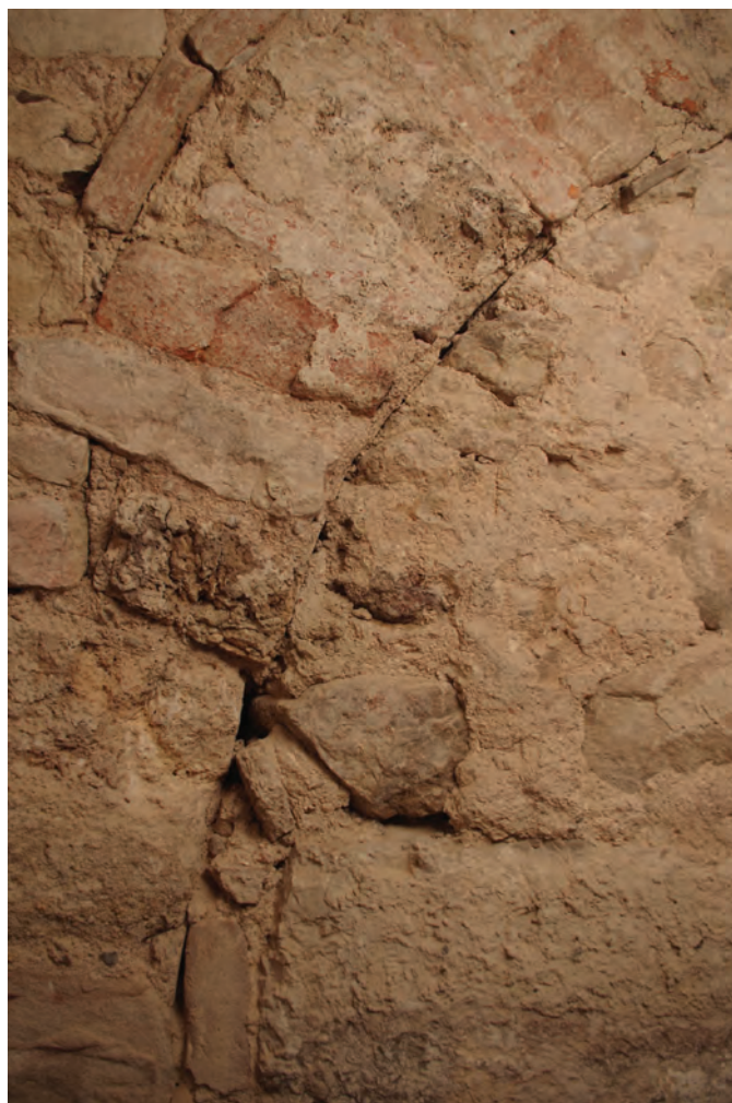
a. Enduit conservé sur l'intrados de l'arc, côté ouest.
