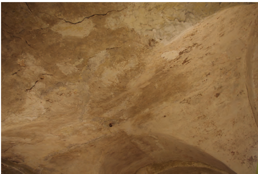
a. Voûte d'arêtes couverte d'enduits modernes.
