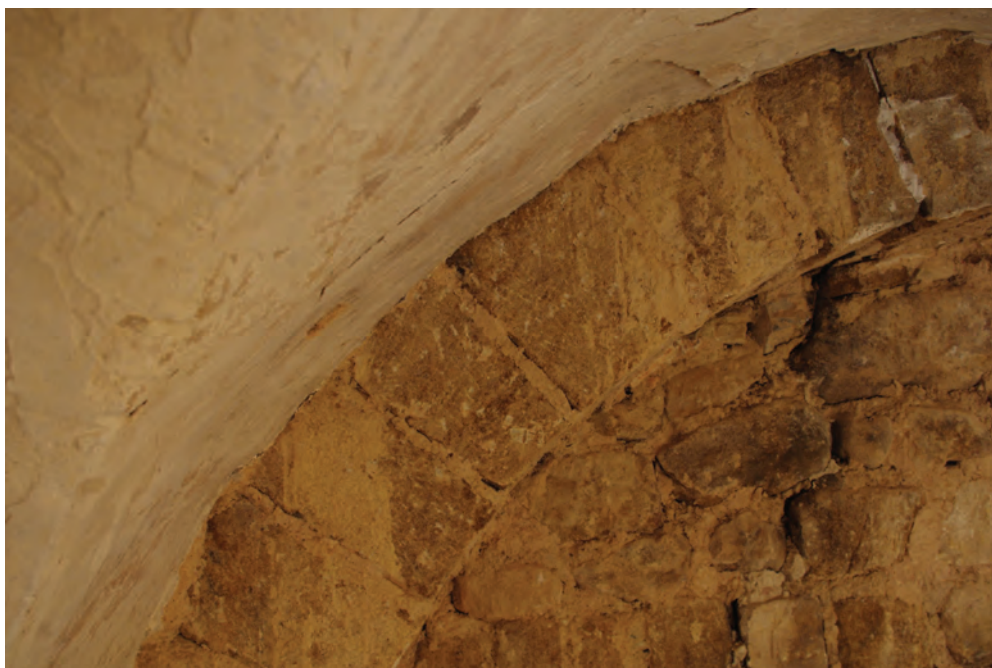
b. Traces de l'enduit original ayant coulé sur certains claveaux de l'arc.
