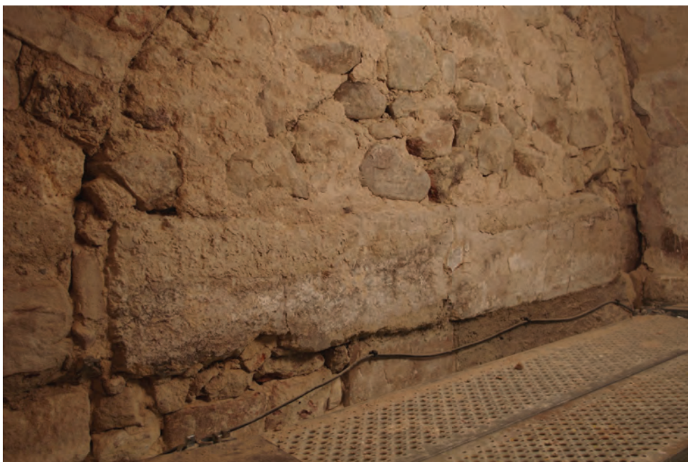
a. Linteau monolithe en calcaire dur.
