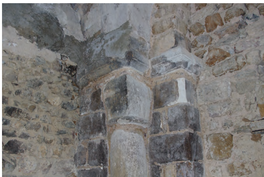
c. Détail du chapiteau épannelé et de l'imposte moulurée.
