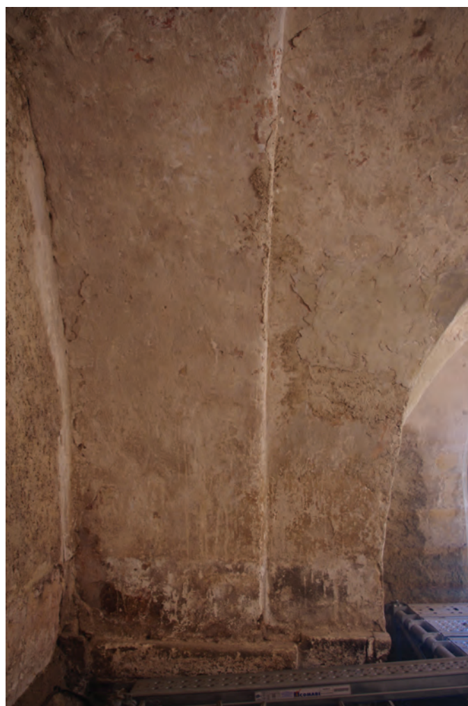
b. Massif d'angle nord-est, retombées de la voûte et de l'arc.
