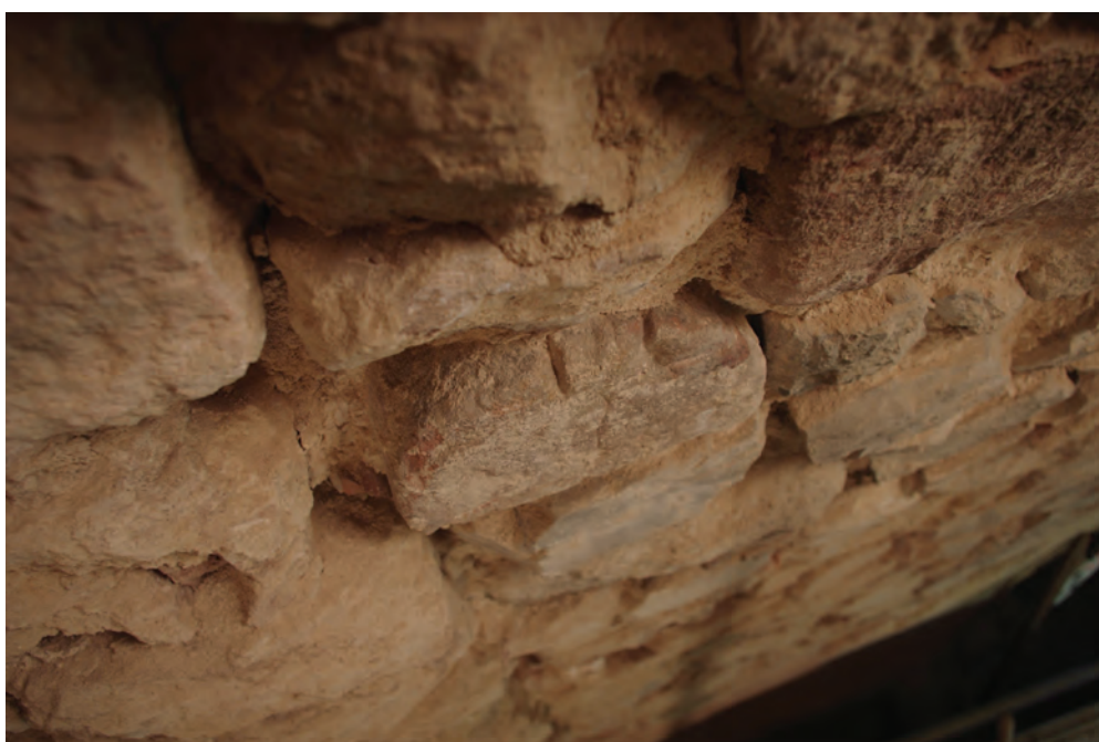
b. Remploi de colonnette sculptée dans ce bouchage.
