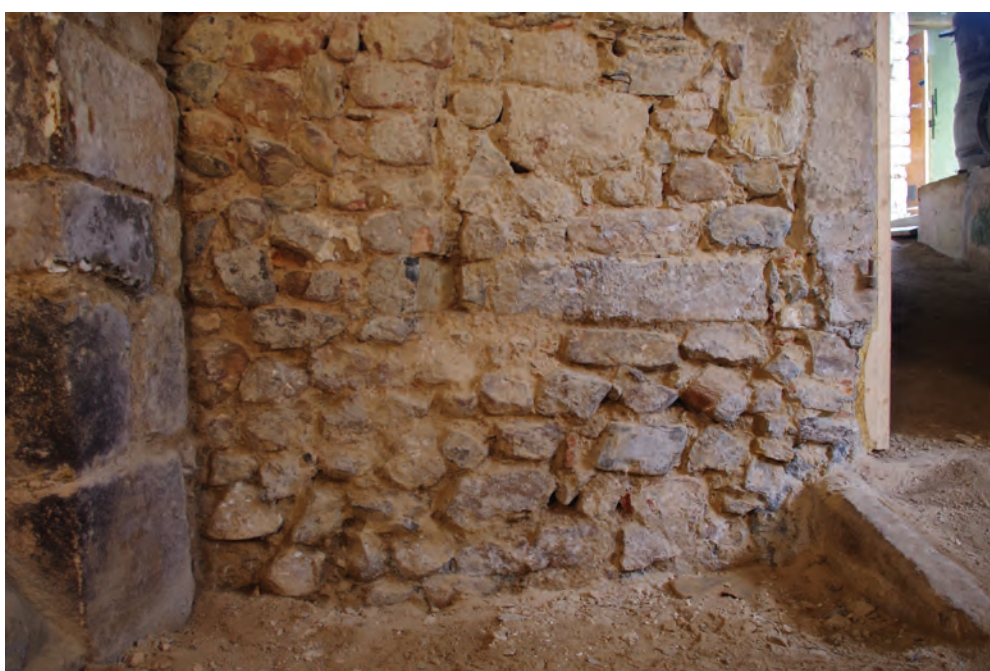
b. Sous le seuil de l'ancienne arcade, structure en saillie qui soutenait sans doute un escalier.
