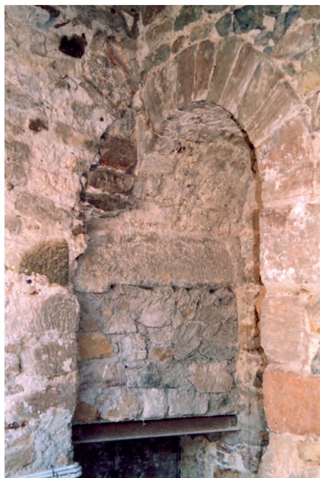
b. Arcade aveugle à l'extrémité sud du mur, permettant de conserver un accès vers la chapelle
