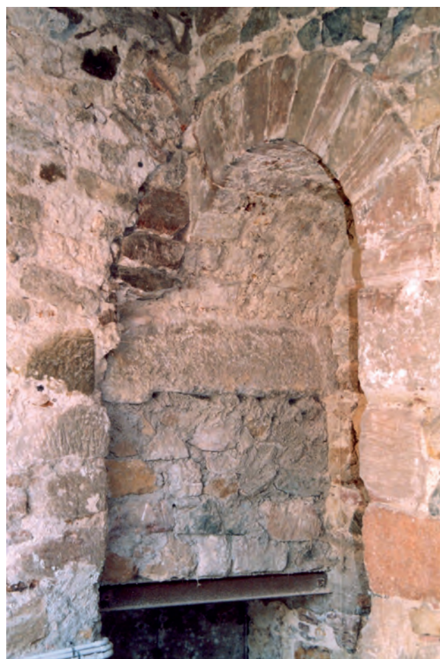
b. Arcade aveugle à l'extrémité sud du mur, permettant de conserver un accès vers la chapelle
