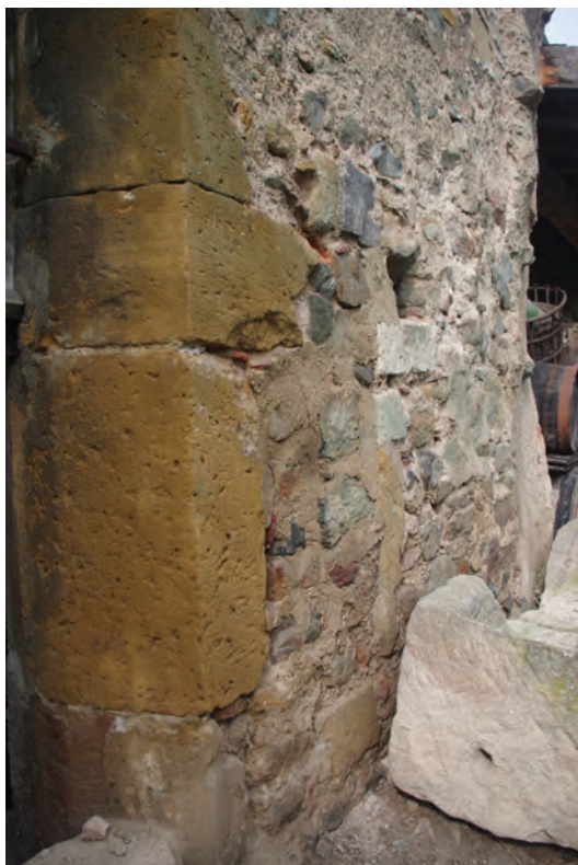
b. Vestiges d'une ancienne fenêtre détruite par la baie actuelle.
