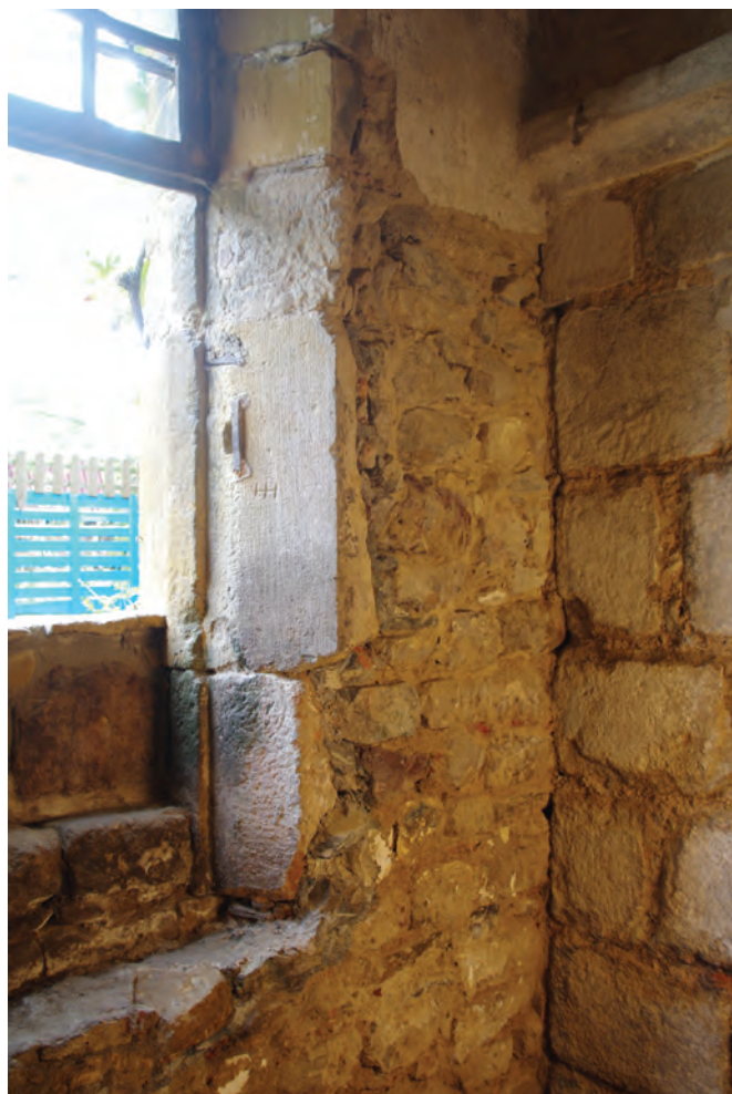
b. Jonction entre le mur, y compris le bouchage de l'ancienne fenêtre, et le massif d'angle sud-est.
