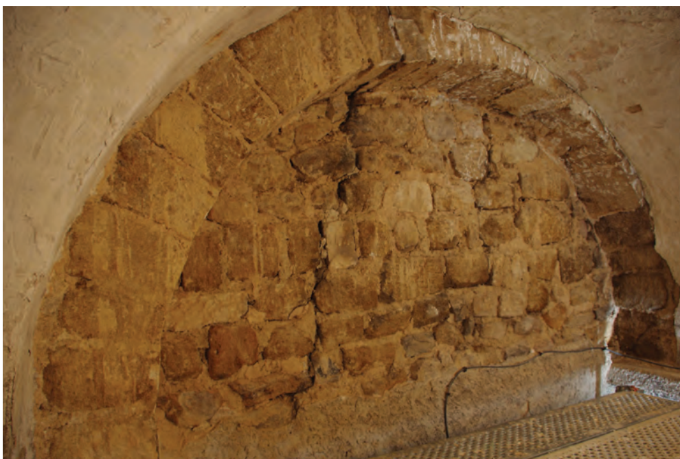
a. Arc et paroi murale présentant une importante fissure.
