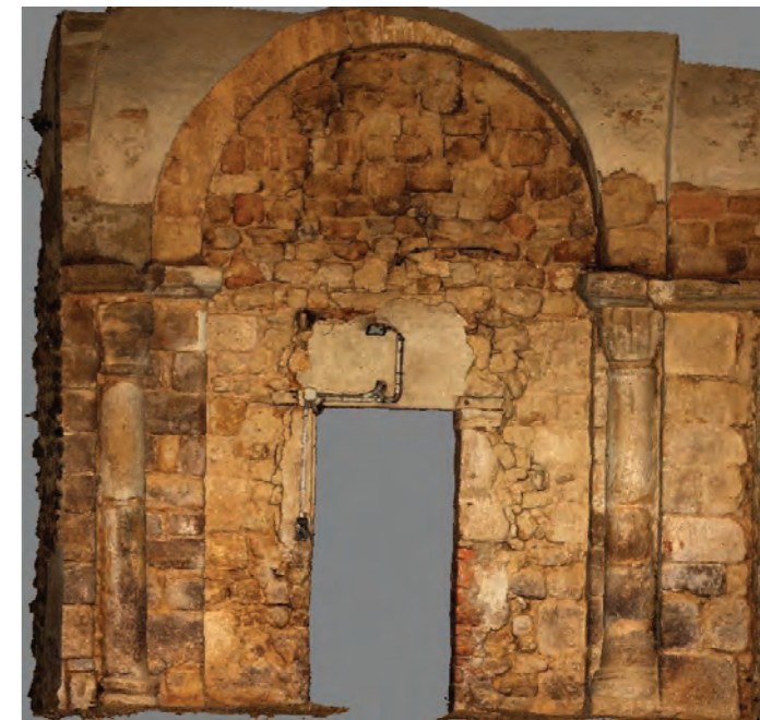
h. Mur ouest.
