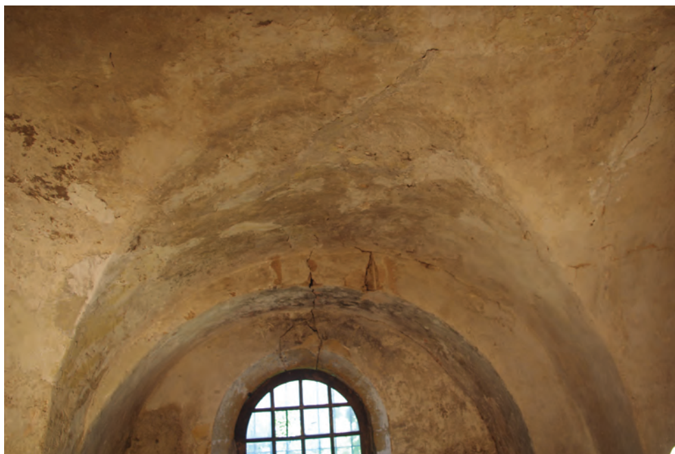
a. Arêtes et voutain du côté de l'arc est.
