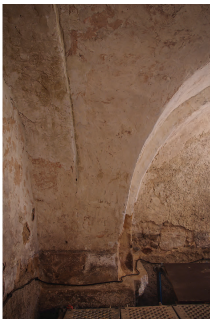
b. Massif d'angle nord-ouest et retombée septentrionale de l'arc ouest.
