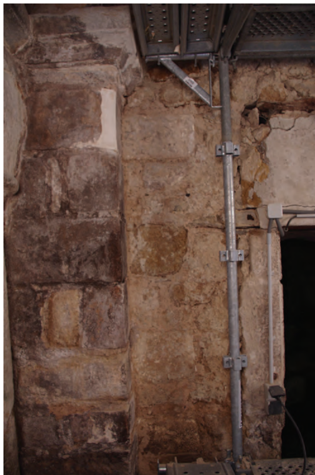
a. Chaînage en grand appareil et césure périmétrale autour de la porte actuelle.
