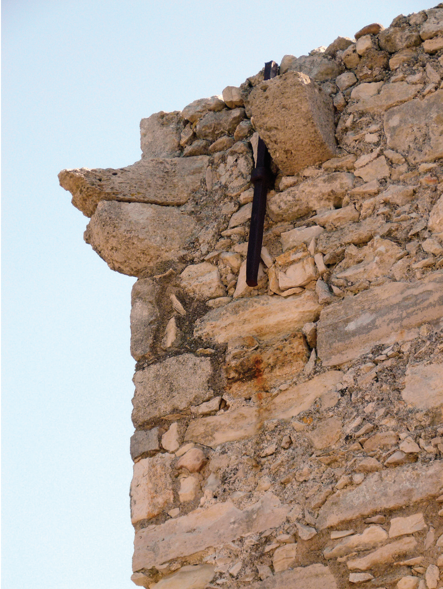
Fig. 8 - Vue de détail des consoles de la tourelle d'angle disparue, depuis le nord-ouest (Cliché V. Rinalducci, CNRS)
