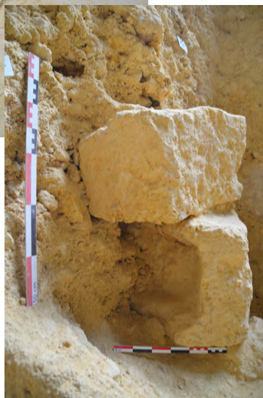
Fig. 56 - Vue de détail du pied de cuve remployé dans le mur F. 23
