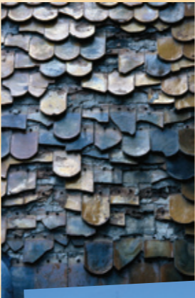
Brignoles, protection de façade, cliché : CNRS-LA3M.
