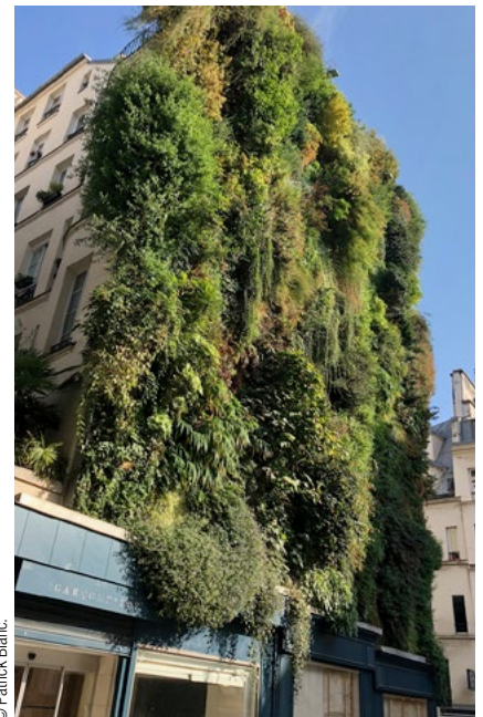
Mur végétal, rue d'Aboukir, Paris (2 ème arr.).
