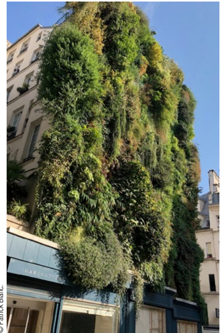
Mur végétal, rue d'Aboukir, Paris (2 ème arr.).
