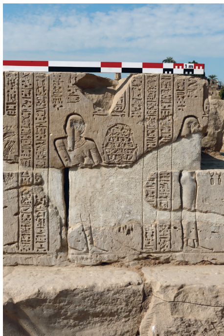
4. Restauration du mur péribole est. © Ifao/G. Pollin.
