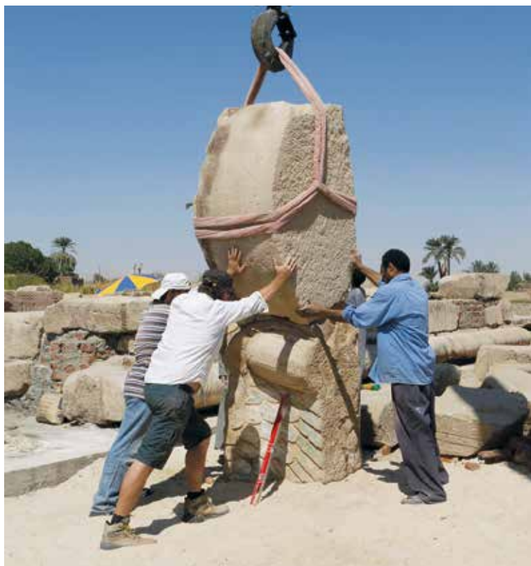
Fig. 155. Assemblage de deux blocs de corniche.
