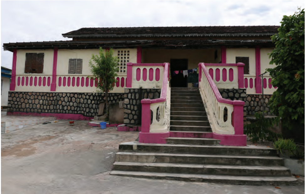
La résidence d'Obodji Soboa , au quartier Obodjikro à Agboville, lui servait aussi de lieu de réception. Elle n'est plus habitée mais est préservée et a relativement bien résisté au temps. En 2019, toutefois, sa toiture était en partie effondrée. Les pièces et quelques éléments du mobilier d'époque, dont un élégant sommier de lit avec poteaux en métal, témoignent du faste du train de vie de ses habitants (cliché de l'auteur, juillet 2019).
