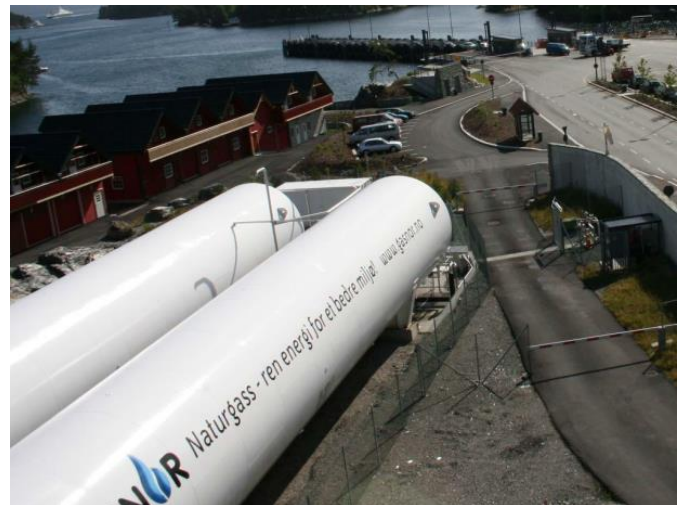
Stockage local de GNL en Norvège
