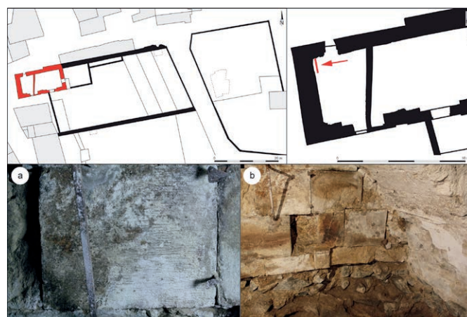
Fig. 14 Emprise de l'avant-nef, étude du bâti : détail du revers de façade avec des traces de layage horizontal sur un bloc de calcaire blanc (a) et des dalles de pierre retailées au moment de la mise en œuvre (b) (cl. Olivia Puel, 2009).
