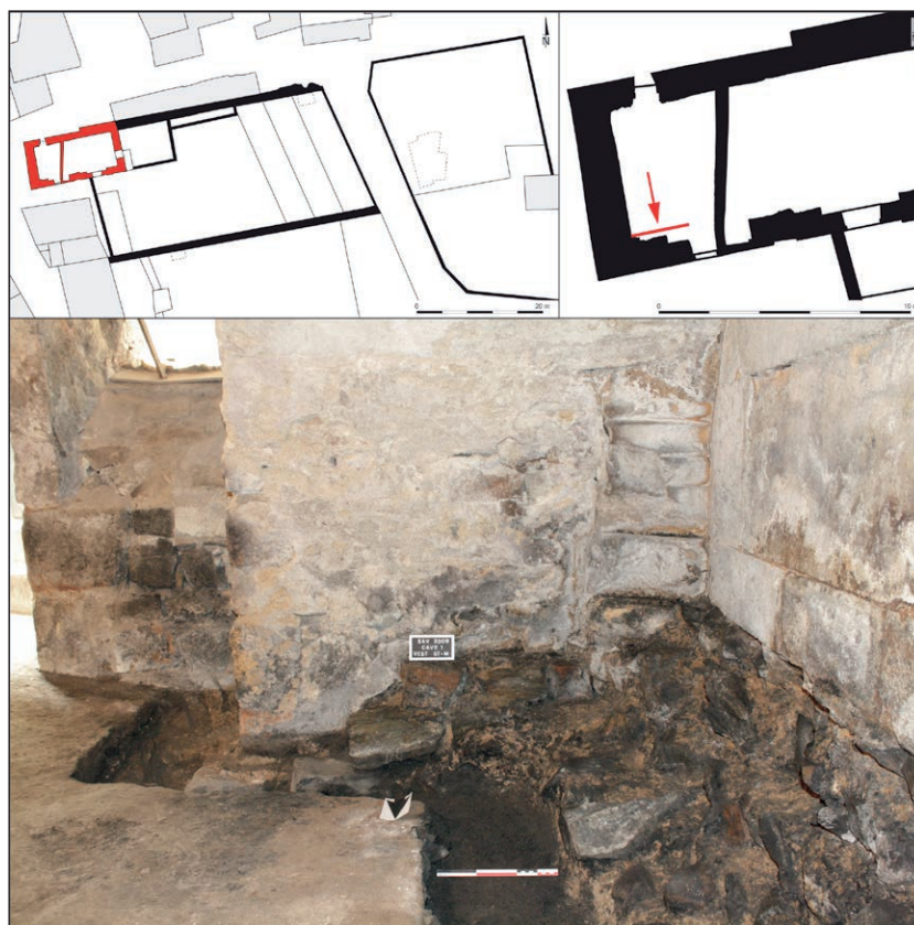
Fig. 12 Emprise de l'avant-nef, étude du bâti : angle sud du mur de façade. À droite : en bas, les fondations saillantes; en haut, le placage de grand appareil sur l'élévation; au fond, les vestiges du pilier ouest (cl. Olivia Puel, 2009).
