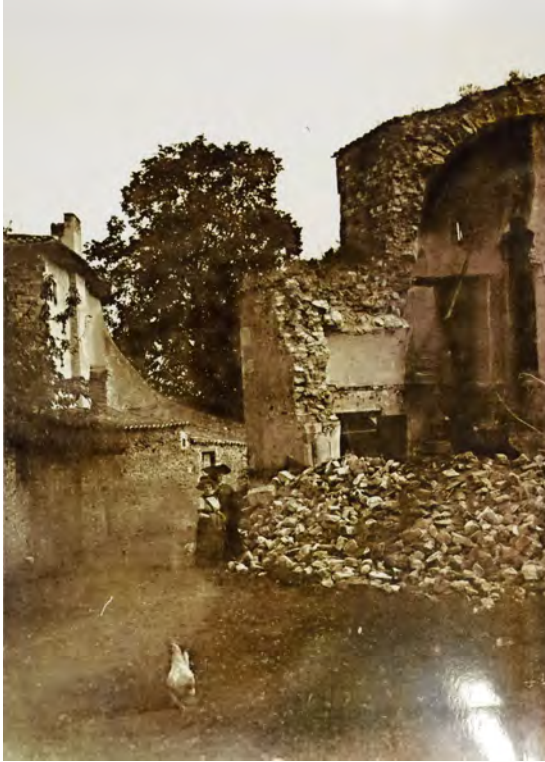
Figure 9. Vue ancienne des vestiges de l'église Sainte-Marie prise depuis l'ouest par Amédée Cateland (avant 1914).
