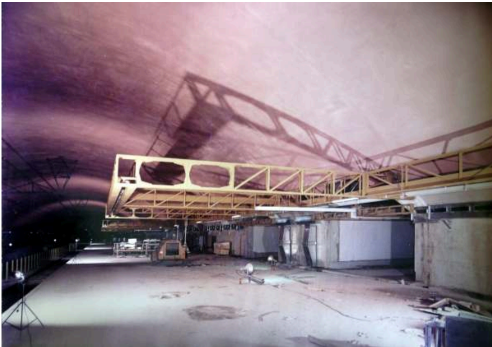
Figure 9. Station « Nation », pose des consoles techniques.
