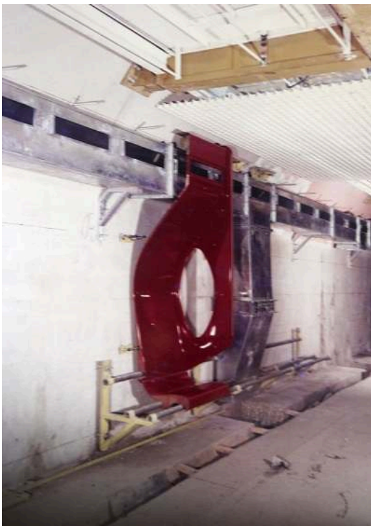
Figure 3. Station « Nation », pose des assises moulées en polyuréthane.
