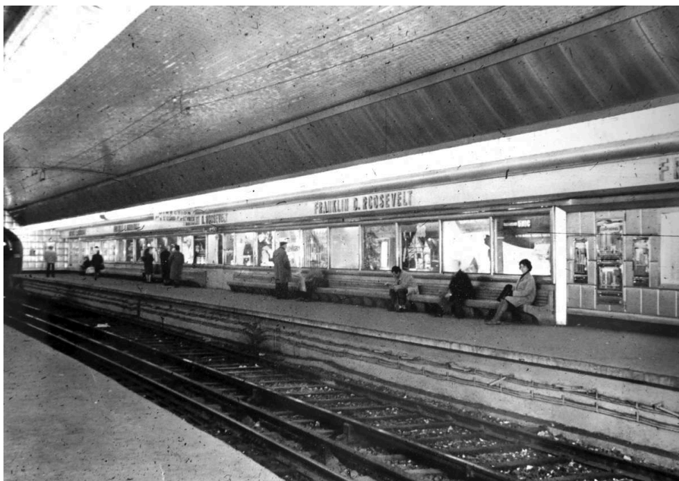
Figure 12. Photographie de la station « Franklin D. Roosevelt » (ligne 9).
