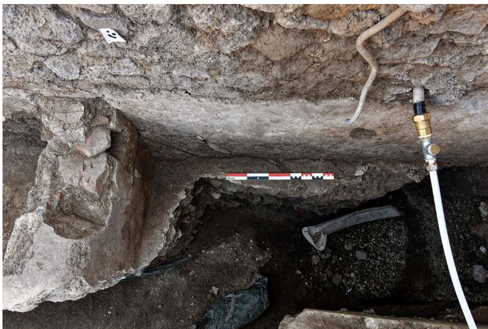
Fig. 14 – Pompéi, VI 16, 3-4, pièce 1E. Bassin (163154) vu de dessus. Son fond a été perforé par une tranchée creusée peu avant l'éruption pour installer un tuyau en plomb d'adduction en eau.
