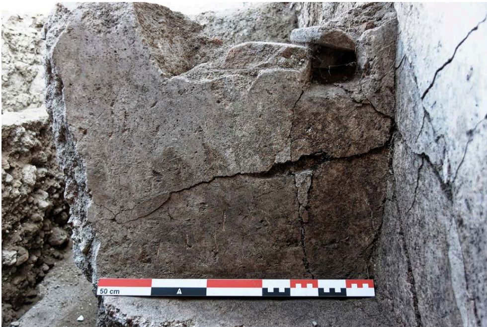
Fig. 15 – Pompéi, VI 16, 3-4, pièce 1E. Orifice de remplissage du bassin (163154). Vue du sud.
