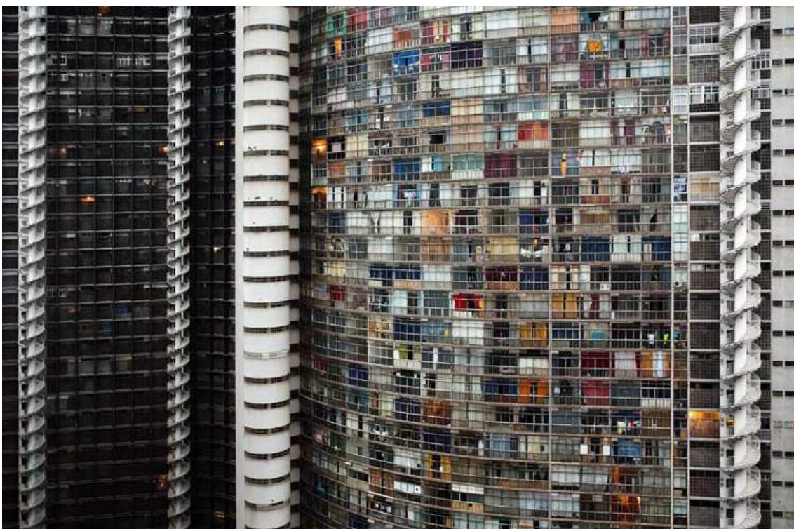
Photo 7 Immeuble du centre de São Paulo
