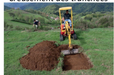
Creusement des tranchées
